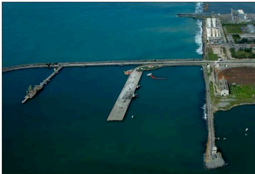
Figura 14: Cais de Múltiplos Usos - CMU
