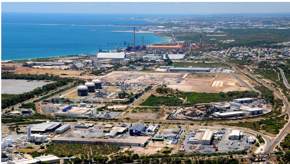
Figura 06: Área Industrial de Kwinana
