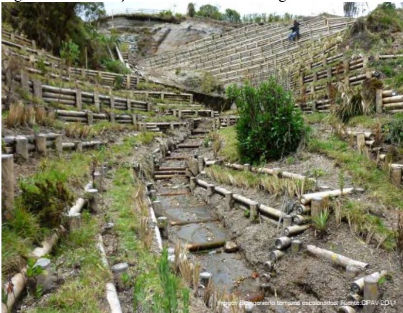
Figura 17 - Contenção de encosta com bioengenharia.
