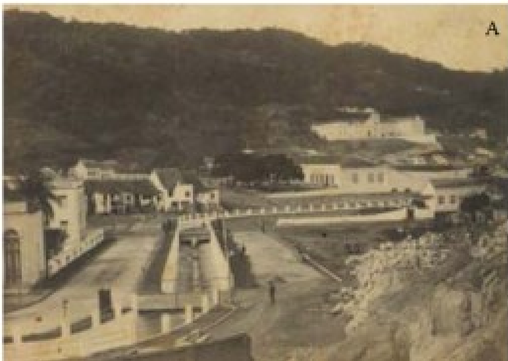
Figura 3 - Obras de canalização do Rio da Fonte Grande.
