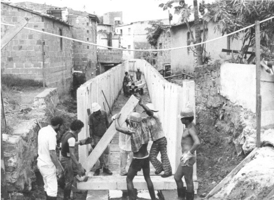
Figura 50 - Execução de canalização no Bom Juá.
