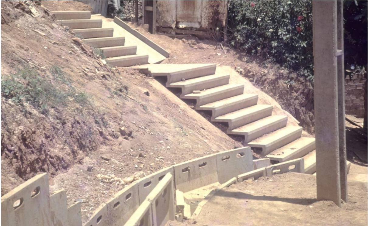
Figura 48 - Encaixe das peças em argamassa armada.
