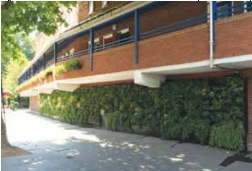
Figura 12 - Parede verde com vasos horizontais abastecida pelas calhas do prédio.
