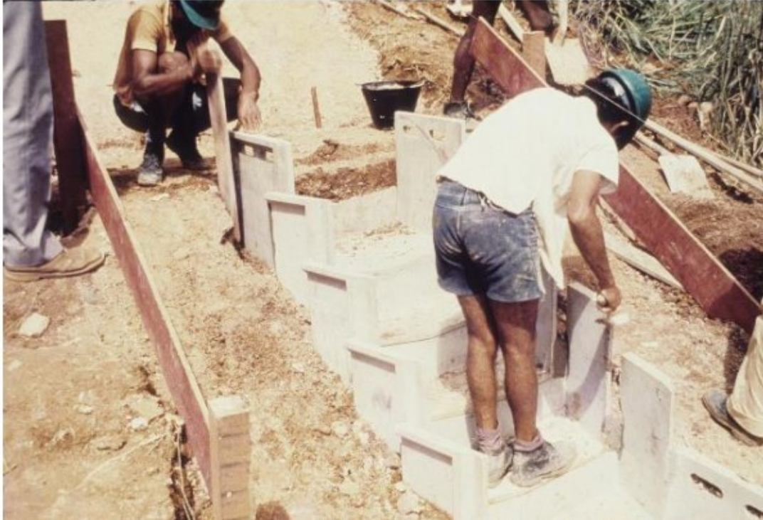
Figura 49 - Execução da montagem das escadas drenantes.
