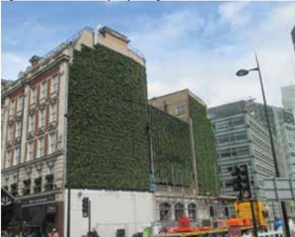
Figura 11 - Parede verde tipo tapete vegetal.
