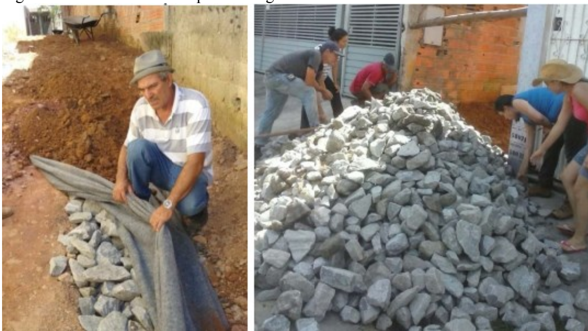
Figura 46 - Blocos de rachão para drenagem dos canteiros.
