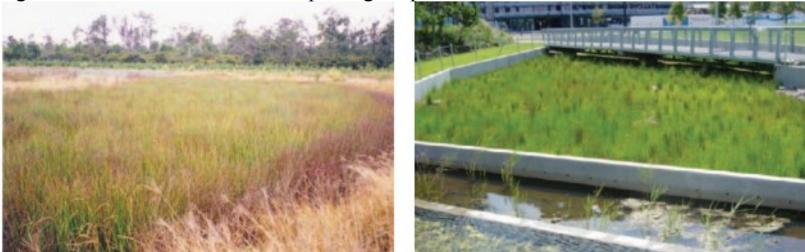
Figura 14 – Wetlands construídos para águas pluviais.
