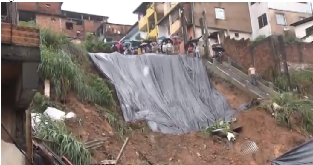
Figura 69 - Deslizamento com fatalidades no Bom Juá.
