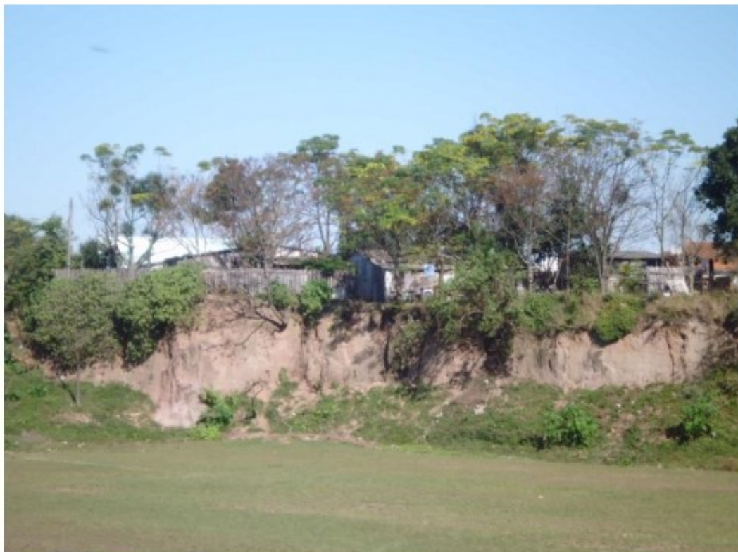
Figura 76 - Encosta com erosão em Nova Santa Marta.
