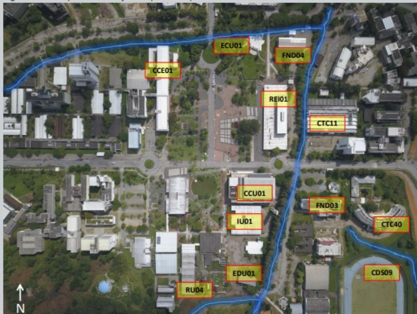
Figura 03: Exemplo de edificações importantes para o funcionamento da universidade localizadas em APP.
