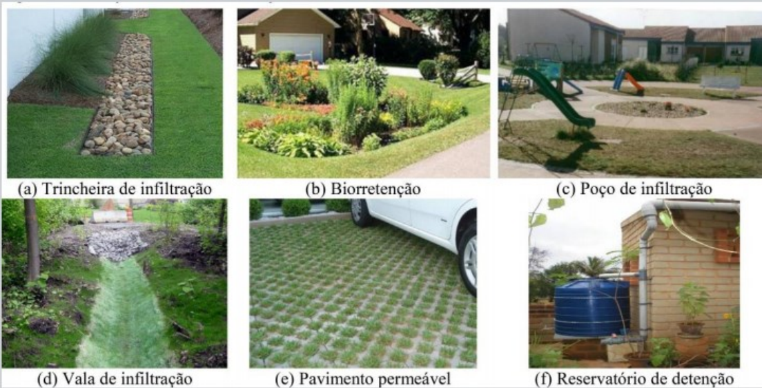
Figura 06: Exemplos de técnicas compensatórias em drenagem urbana.
