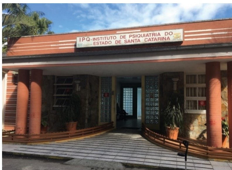
Figura 42 - Entrada principal do IPq-SC.
