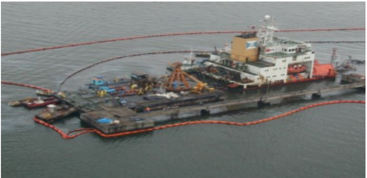
Figura 4: Retirada do castelo do navio
