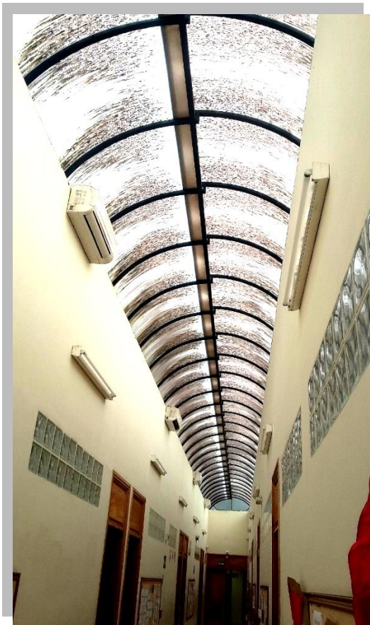
Figura 27 - Teto do prédio do CES vista do corredor interno
