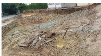
Figura 2: Limpeza do terreno. Fonte: Autores (2017).
