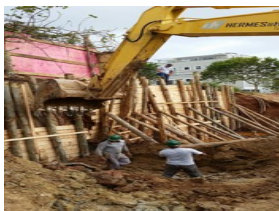
Figura 3: Contenção de terra. Fonte: Autores (2017).
