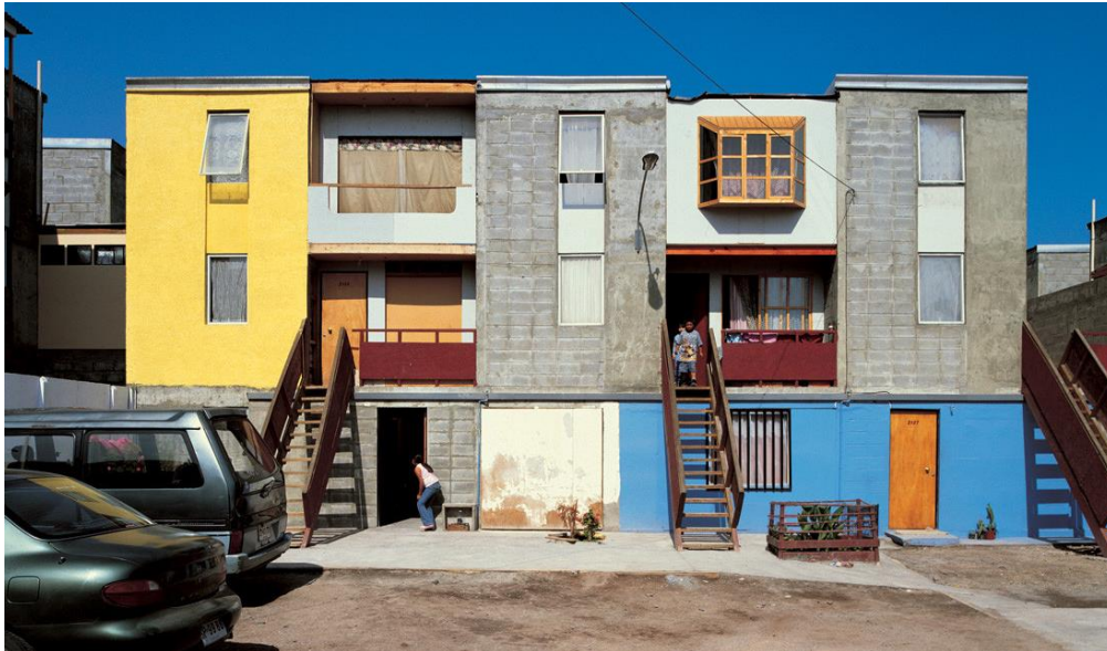
Figura 3: Fachada do Quinta Monroy. Fonte: Archdaily, 2004.
