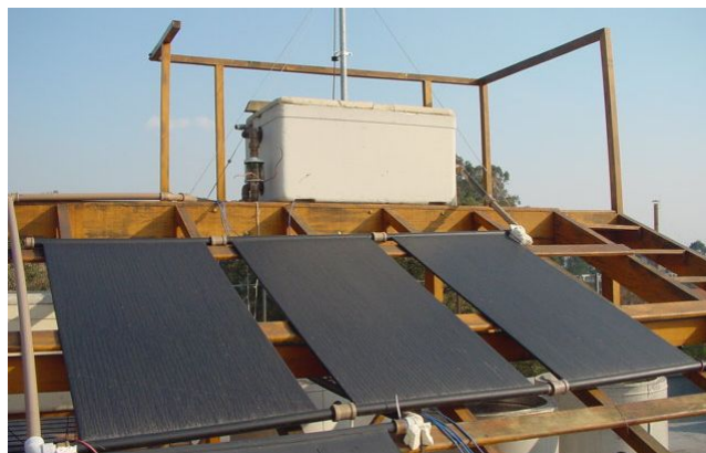
Figura 2 – Sistema ASBC formado por placa de PVC.
