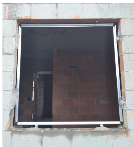
Figura 5: Contramarco chumbado no vão osso. Fonte: Acervo próprio das autoras.
