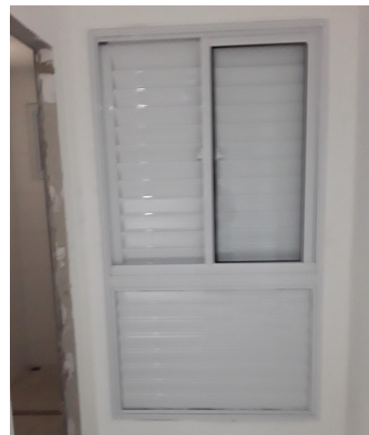
Figura 3: Esquadria instalada faceada internamente. Fonte: Acervo próprio das autoras.
