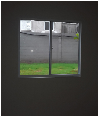
Figura 2: Esquadria instalada centralizada no vão. Fonte: Acervo próprio das autoras.
