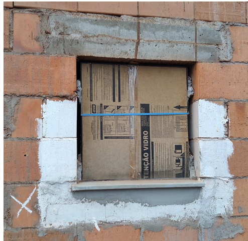
Figura 4: Esquadria chumbada diretamente no vão osso. Fonte: Acervo próprio das autoras.
