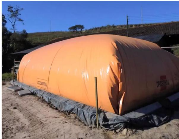
Figura 2: Biodigestor modelo canadense. Fonte: Epagri, 2021.
