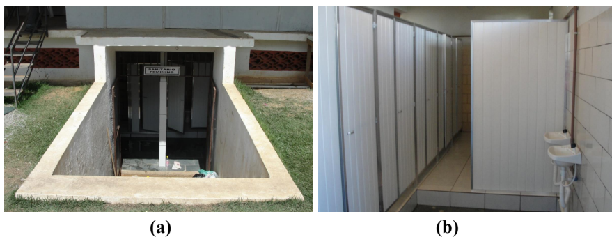
Figura 12: (a) Banheiros. (b) Sanitários Femininos. Fonte: Costa (2015)
