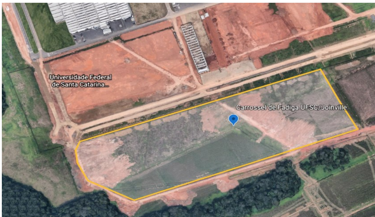
Figura 3.1 - Opção 1 de área para implantação do projeto no condomínio industrial Perini Business Park.
