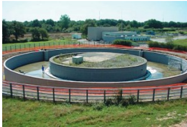
Figura 2.15 - Estrutura de concreto reforçado do anel C.
