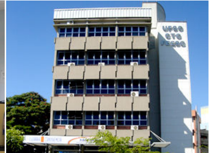
Figura 3: Detalhe do brise horizontal na fachada noroeste. Fonte: elaborado pelos autores.
