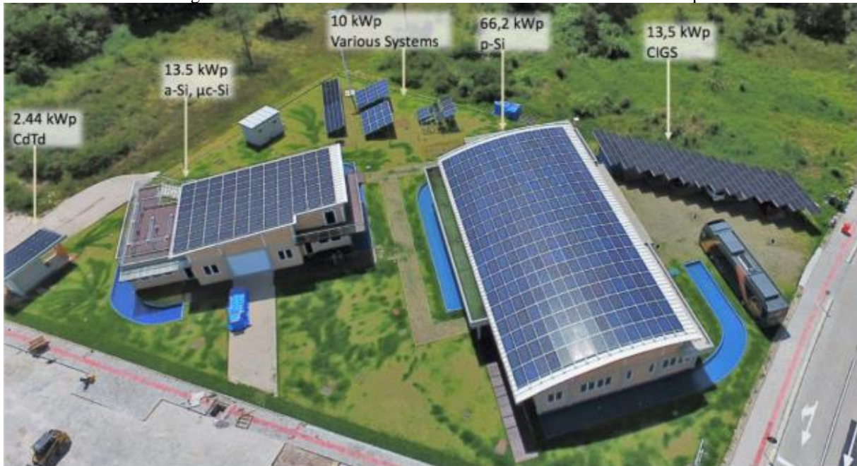
Figura 7 - Sistemas fotovoltaicos do Lab. Fotovoltaica UFSC e suas potências.
