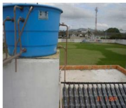
(b) Aquecedor feito de garrafa PET e caixa Tetra Pak
