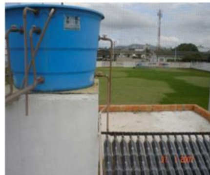
(b) Aquecedor feito de garrafa PET e caixa Tetra Pak
