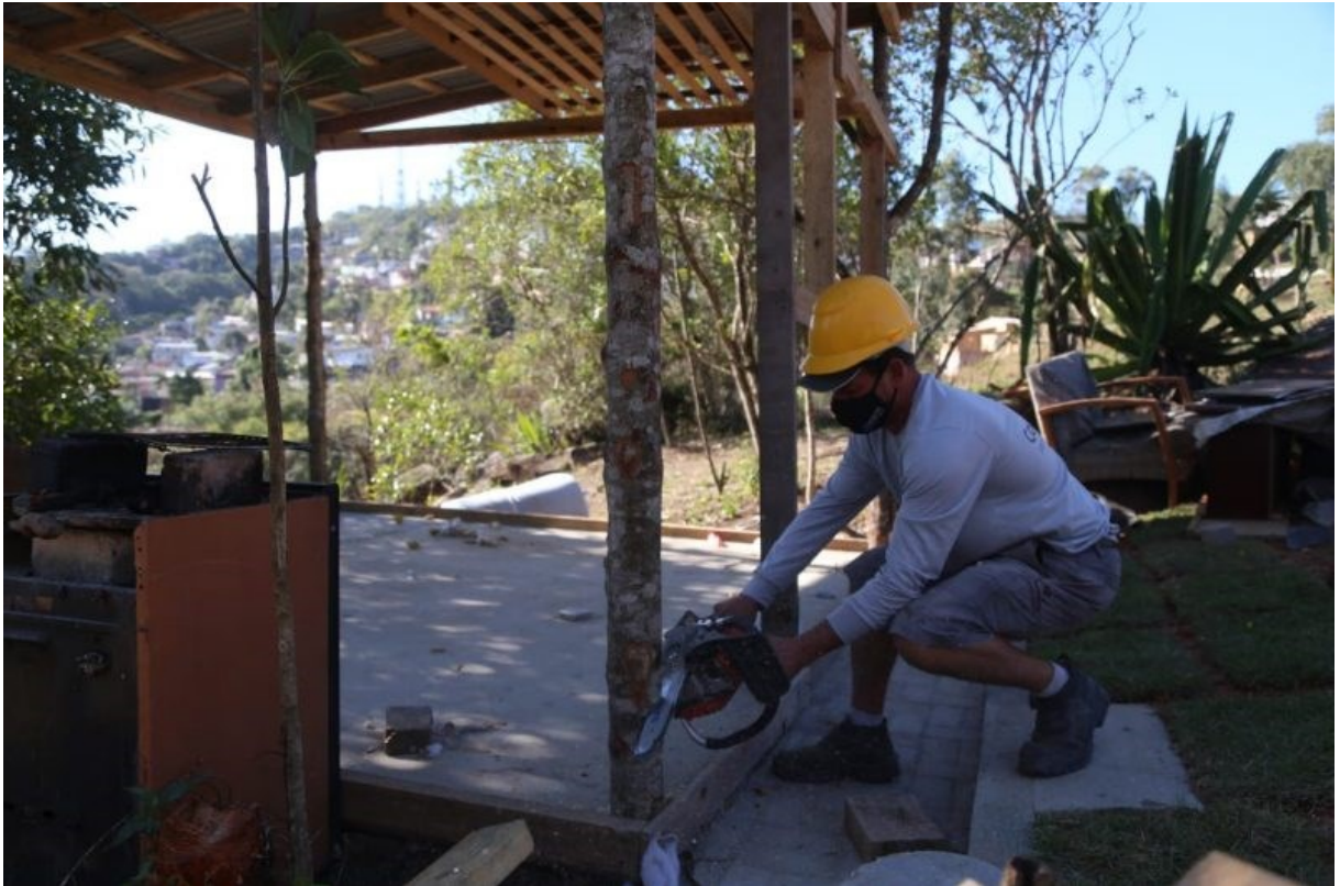
Figura 3 – Registro da ação de demolição de casas no Alto da Caieira. Fonte: Relatório ND, 2020. Autor: Anderson Coelho/ND.
