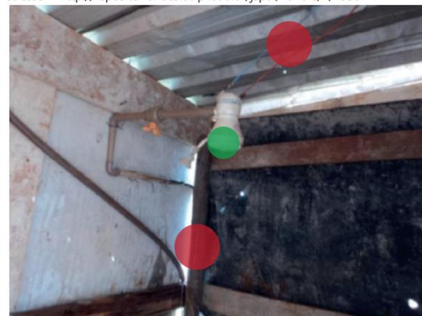
Figura 11 - Chuveiro com instalação elétrica desprotegida. Fonte: Emerson Stresser <<http://repositorio.roca.utfpr.edu.br/jspui/handle/1/1530>>
