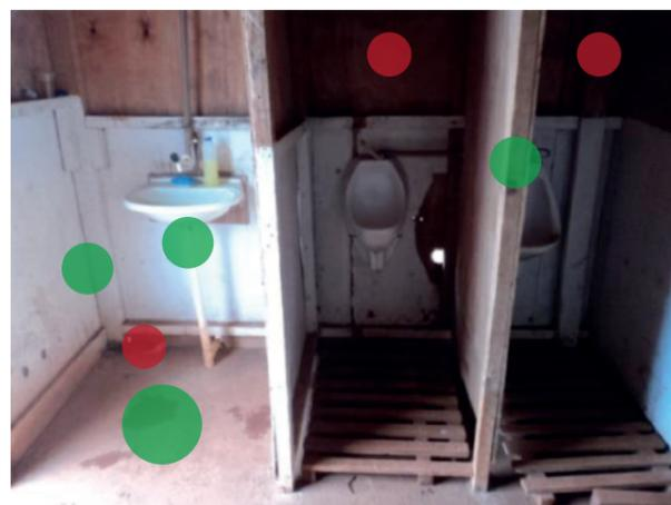
Figura 10 - Instalação sanitária sem ventilação. Fonte: Emerson Stresser <<http://repositorio.roca.utfpr.edu.br/jspui/handle/1/1530>>
