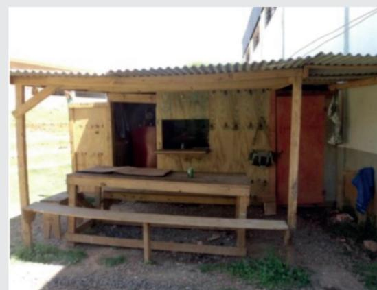
Figura 7 - Barracão de obra em madeira. Fonte: Emerson Stresser <<http://repositorio.roca.utfpr.edu.br/jspui/handle/1/1530>>
