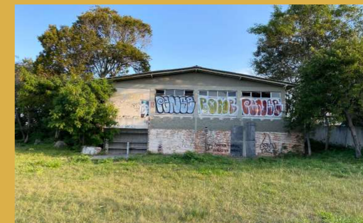
Imagem 77: Construção maior, aparentemente abandonada, do DNIT. Fonte: acervo pessoal.
