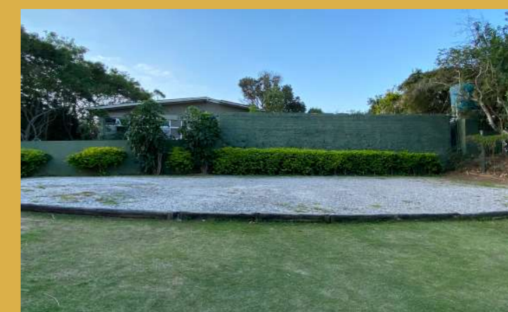
Imagem 79: Muro divisor entre o terreno da GoKite e do DNIT. Fonte: acervo pessoal.
