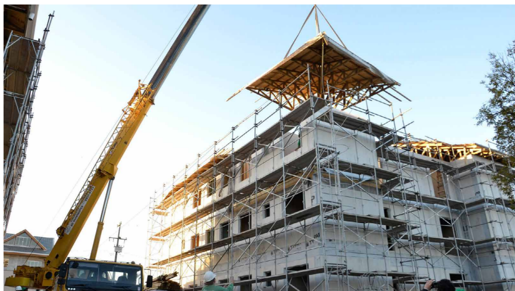
O edifício possui 4 pavimentos no padrão MCMV, executado em woodframe. Inaugurado em 2016 em Araucária, PR. Fonte: tecverde.
