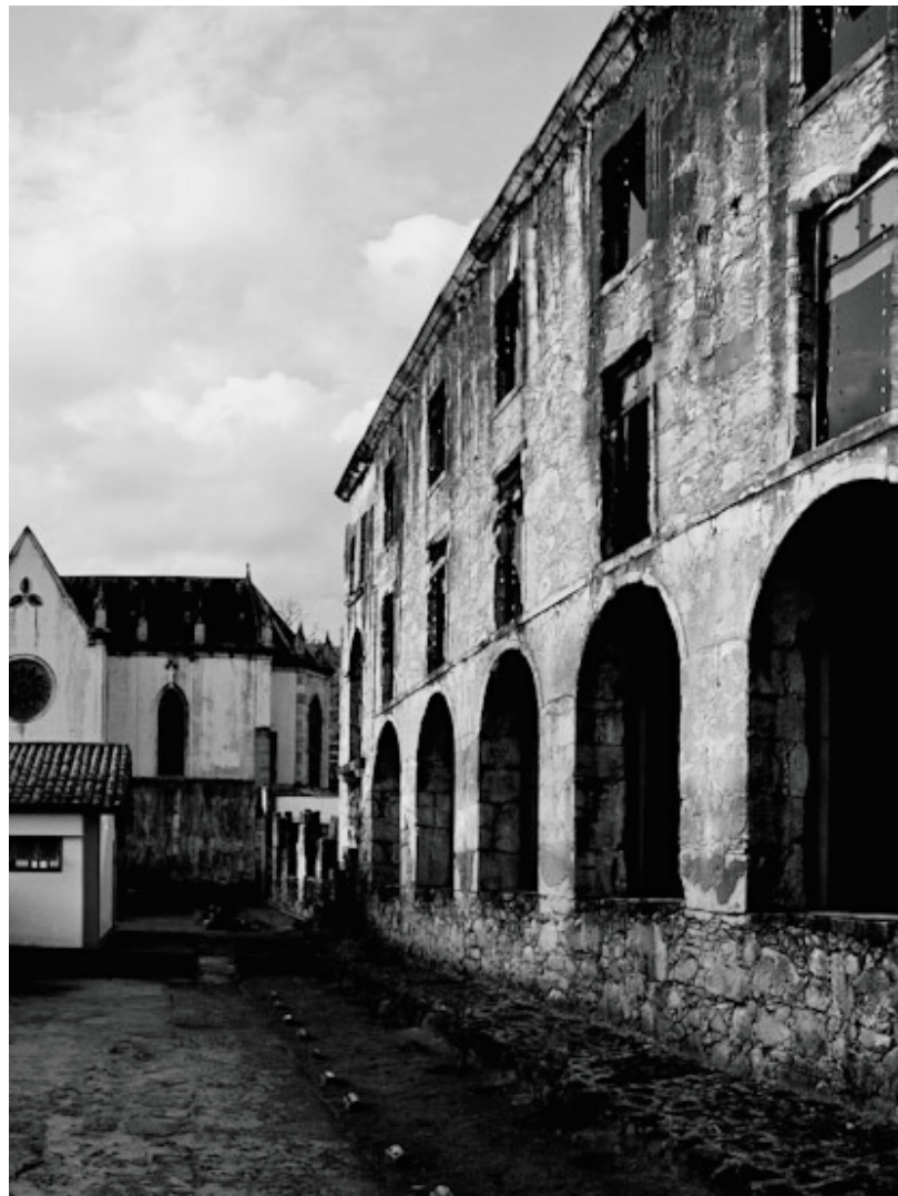
COLÉGIO CARAÇA CATAS ALTAS/MG reabilitação do edifício: espaço museal
