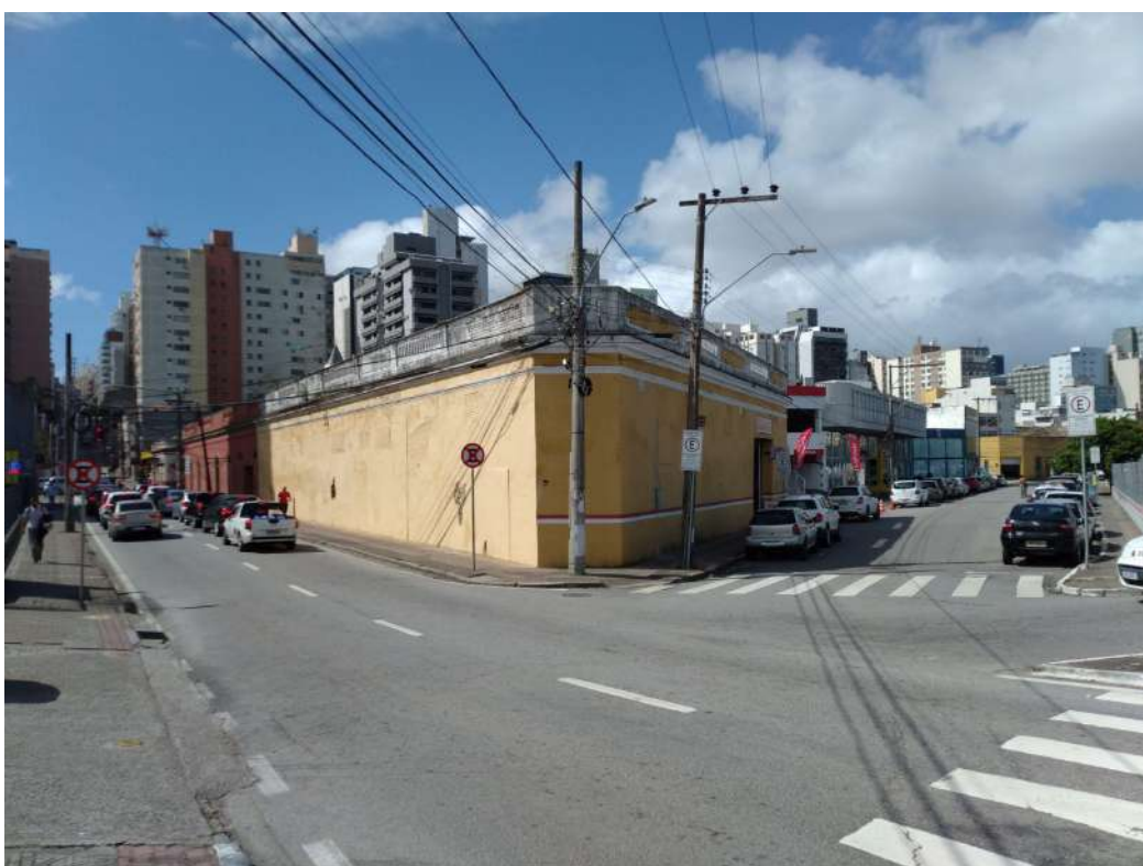
Figura 09. Fachada das duas edificações adjacentes. Fonte: da autora, 2021.
