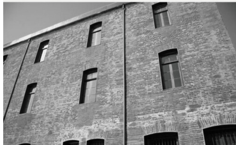
POBLACIÓN OBRERA VALPARAÍSO/CHILE reabilitação do edifício: habitação coletiva
