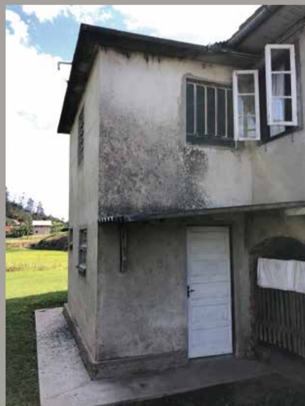
Cobertura vista da fachada Norte Fonte: Arquivo Pessoal
