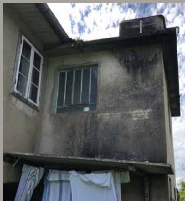
Cobertura vista da fachada Sul Fonte: Arquivo Pessoal
