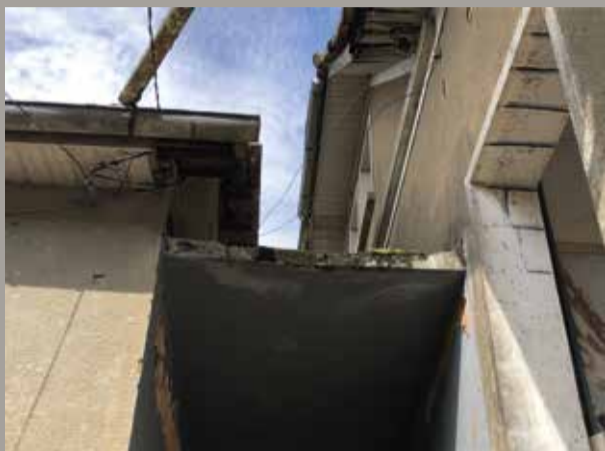
Cobertura vista da fachada frontal Fonte: Arquivo Pessoal
