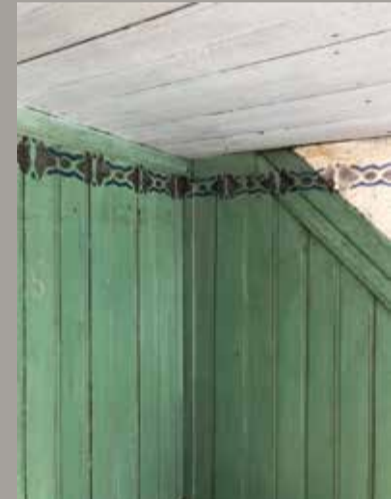
Pintura interna - Sótão
