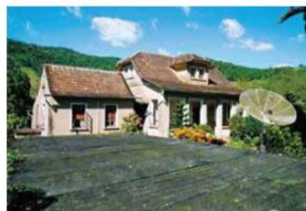
Casa Tamanini, em Rodeio
