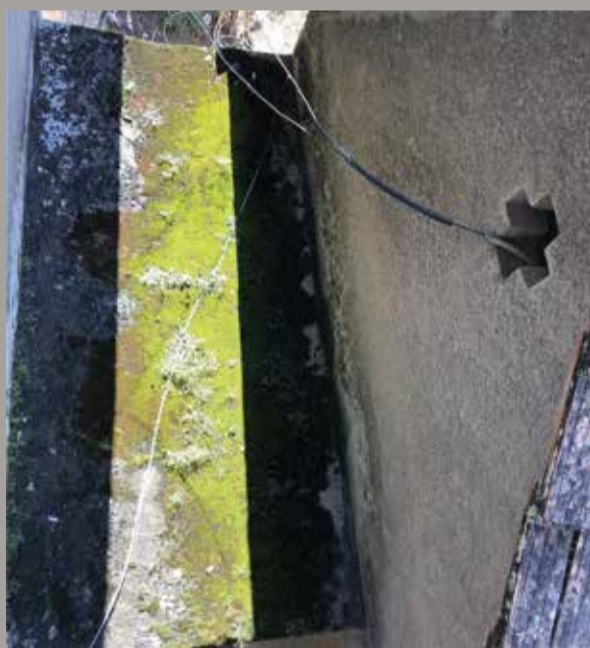
Cobertura vista de cima Fonte: Arquivo Pessoal
