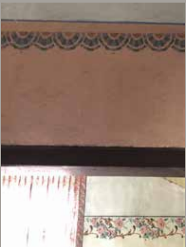
Pintura interna - Corredor
