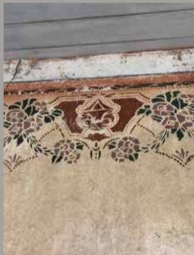
Pintura interna - Quarto 3
