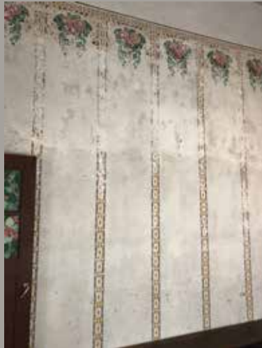
Pintura interna - Quarto 1
