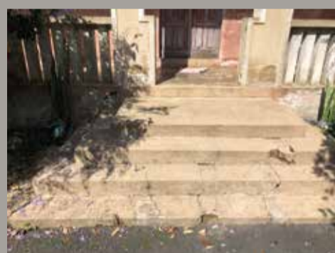
Escada de Acesso - Residência
