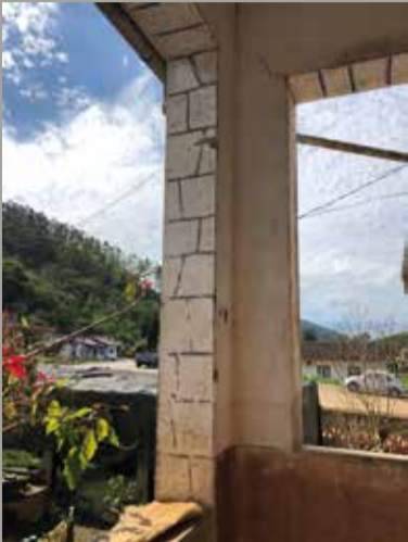
Pinturas em textura de pedra
