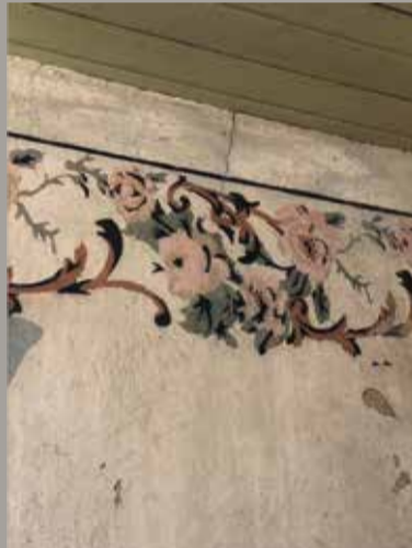
Pintura interna - Quarto 4
