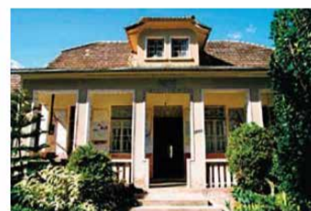
Casa Tamanini, em Rodeio
