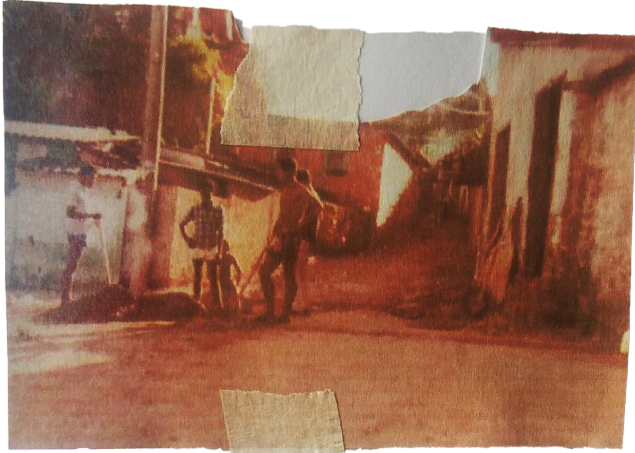
OBRAS NA PPL PELOS MORADORES
