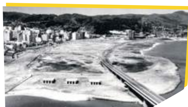
Obras do aterro em 1975 Fonte: Acervo Casa da Memória
