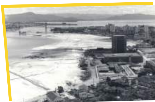
Início das obras do aterro em 1971 Fonte: Acervo Casa da Memória
