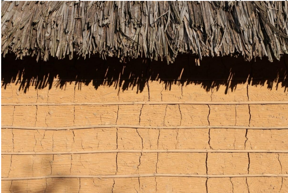
Figura 23 – Paredes de taipa de mão e cobertura em taquara batida, na Opy da Tekoa Vy'a.
