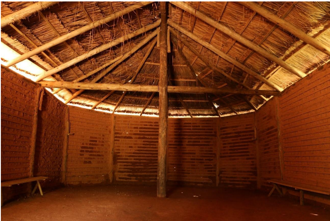
Figura 13 – Interior da nova Opy , com o espaço semicircular ao fundo, Tekoa Itaty, agosto de 2017.
