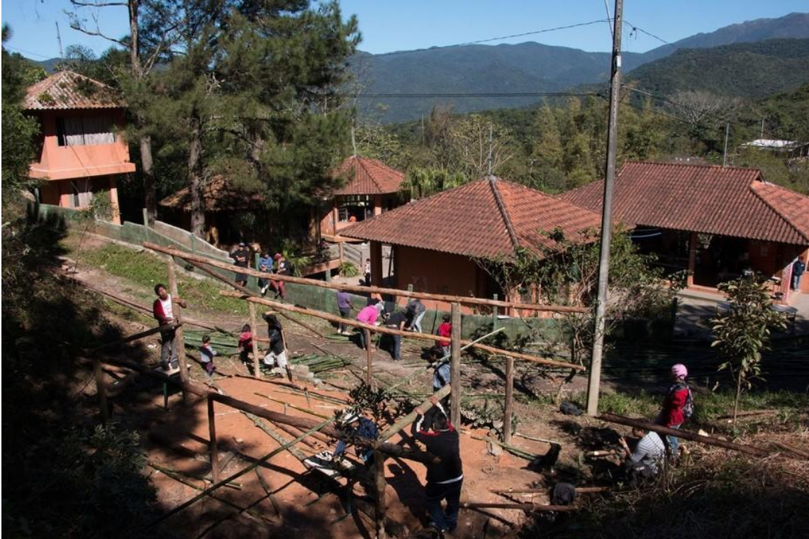
Figura 3 – Construção da Opy Mirĩ ao lado da escola, durante uma atividade escolar; Escola Itaty, plano intermediário; Serra do Tabuleiro, ao fundo. A construção é periódica e faz parte do aprendizado. Os materiais são retirados do próprio lugar e a construção envolve jovens, crianças e professores da escola, além de lideranças e demais moradores.
