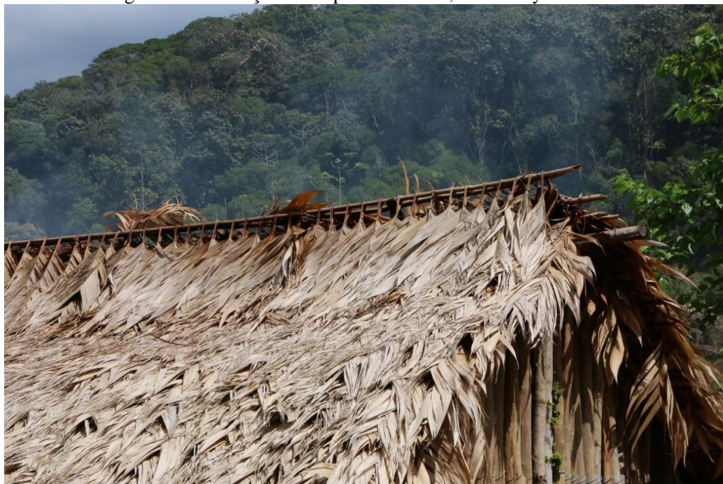
Figura 21 – Fumaça saindo pela cobertura, Tekoa Mymba Roka
