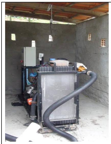
**Figura 04** - Motogerador movido a biogás instalado na propriedade piloto.
