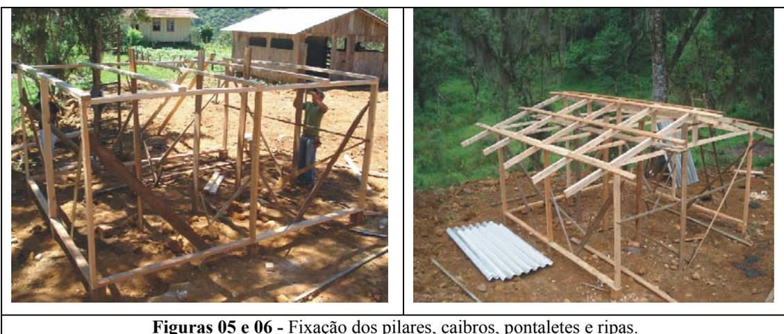
**Figuras 05 e 06 - Fixação dos pilares, caibros, pontalotes e ripas.**
