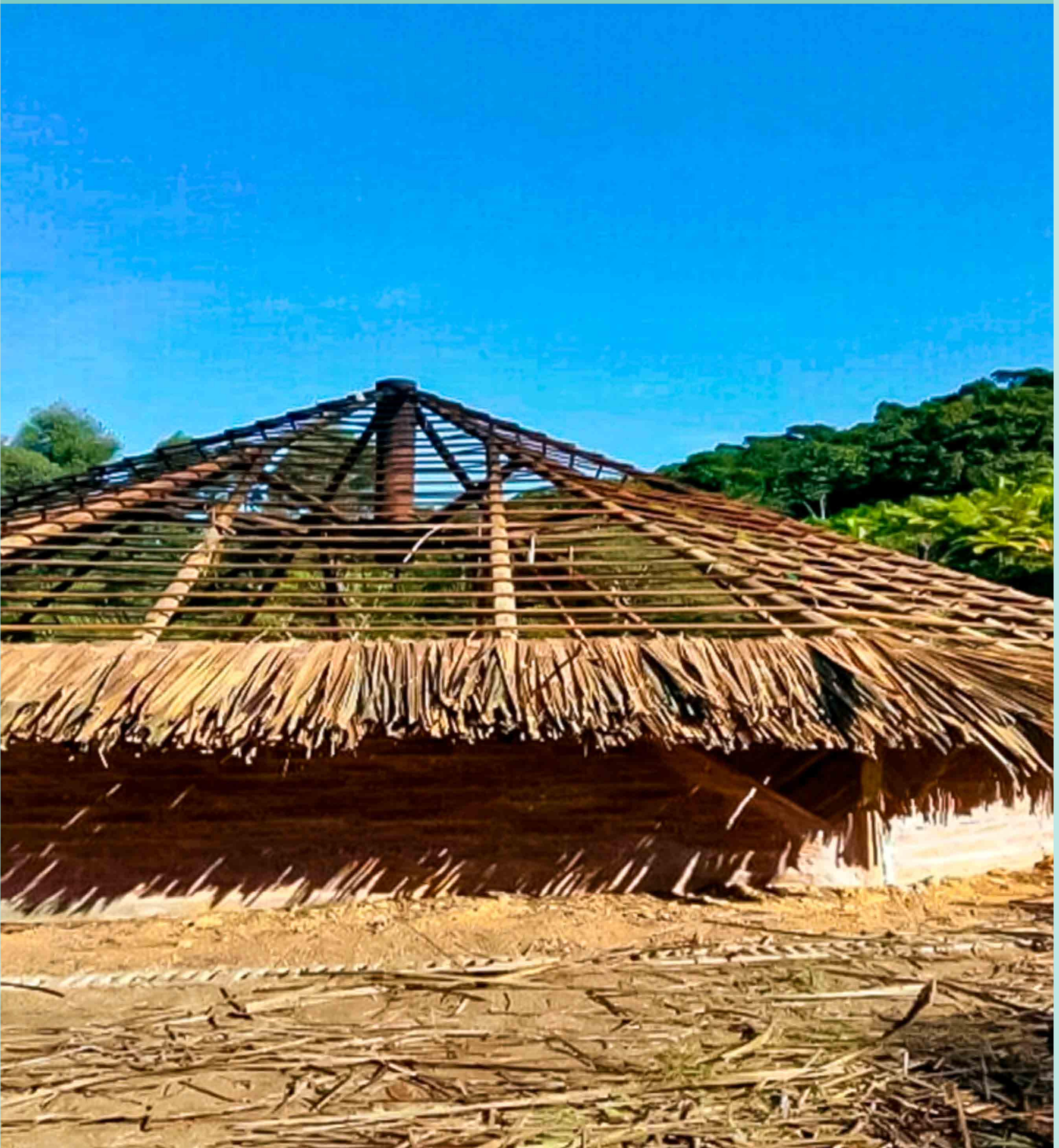
Figura 20: A construção do telhado da Opy, que é depois feito de taquara. Fonte: acervo do autor, 2018.
