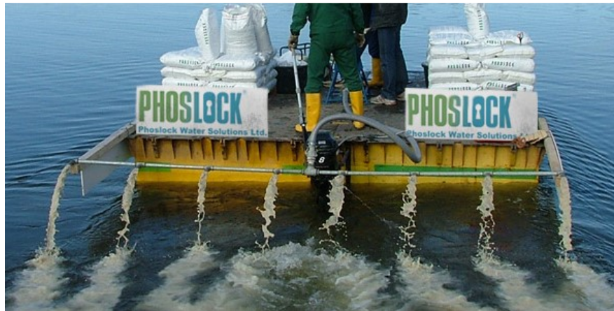
Figura 8. Phoslock® sendo aplicado em um corpo d'água. Imagem retirada da referência 43 .
