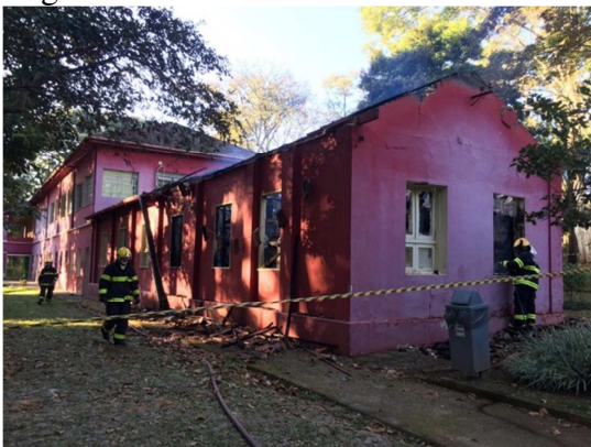
Figura 17 – Incêndio na UFMG – foto 1.
