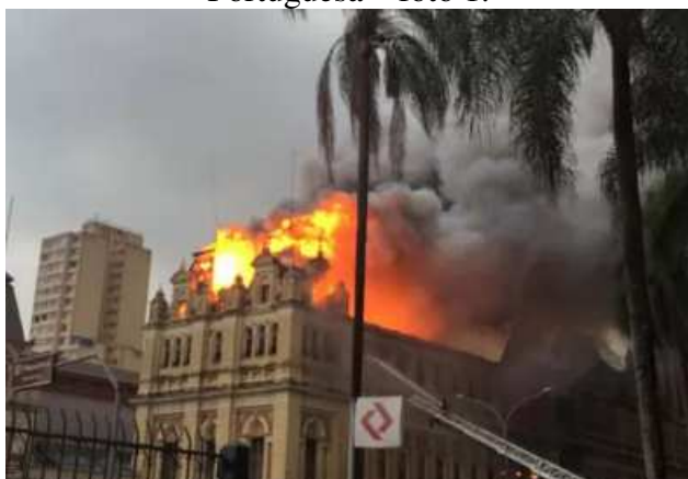
Figura 9 – Incêndio Museu da Língua Portuguesa – foto 1.
