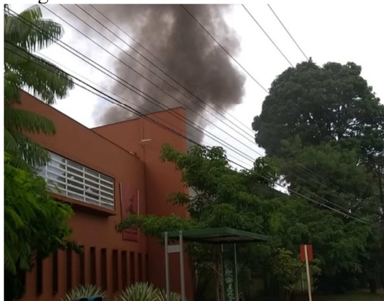
Figura 15 – Incêndio na UFPE – foto 1.
