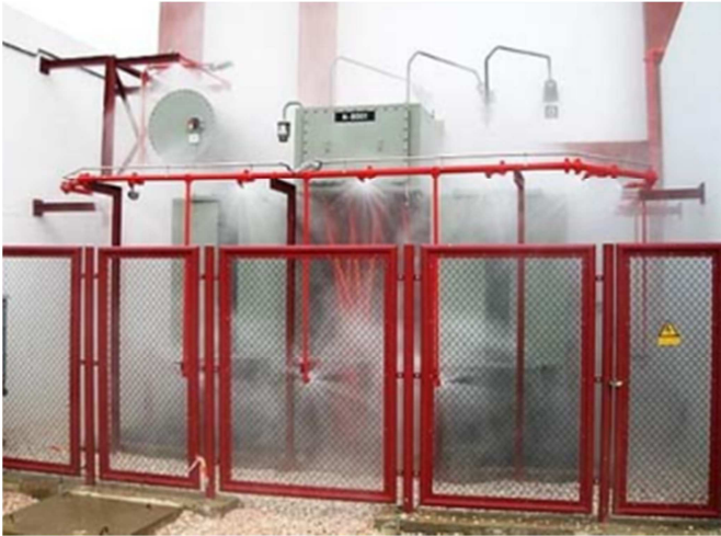
Figura 33 – Sistema de água nebulizada – exemplo 1.
