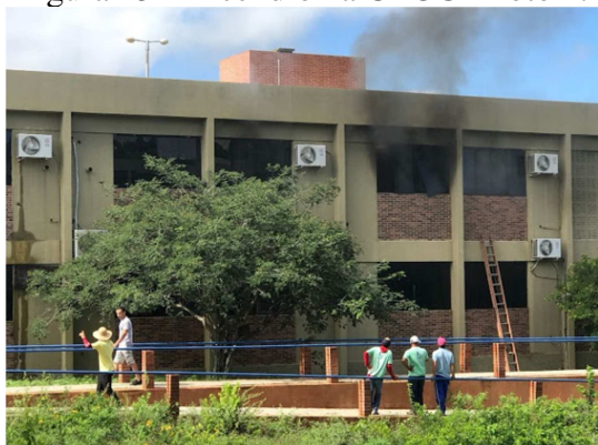
Figura 13 – Incêndio na UFCG – foto 1.
