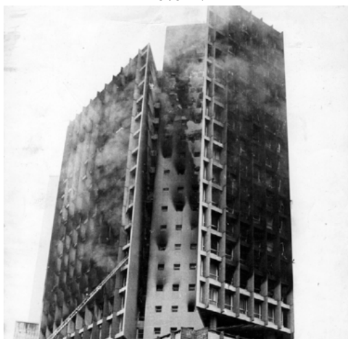
Figura 5 – Incêndio no Edifício Joelma – foto 1.
