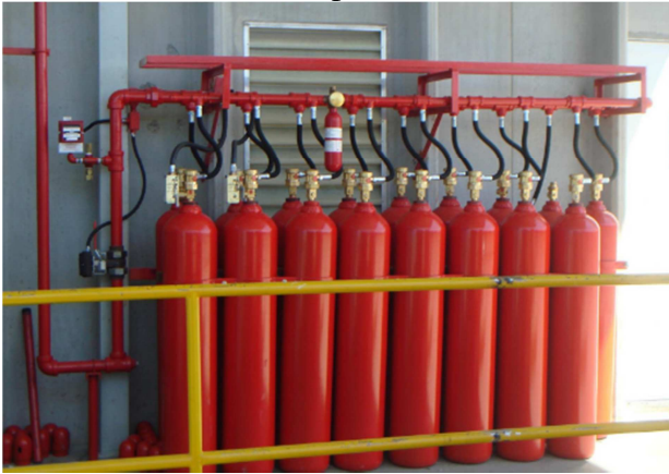
Figura 31 – Sistema fixo com CO2 – exemplo 1.
