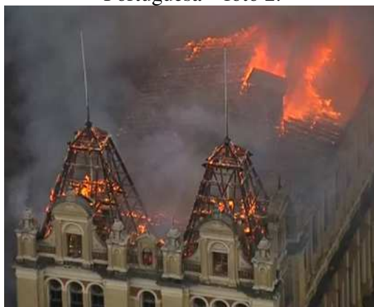
Figura 10 – Incêndio Museu da Língua Portuguesa – foto 2.
