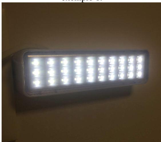
Figura 23 – Luminária de emergência – exemplo 1.
