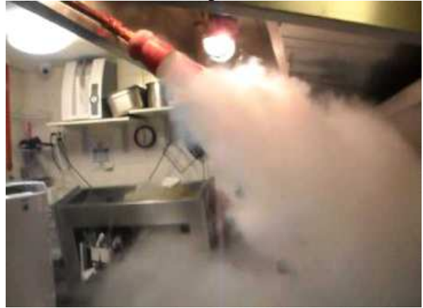
Figura 32 – Sistema fixo com CO2 – exemplo 2.
