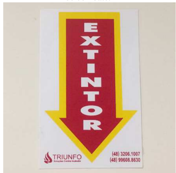
Figura 28 – Sinalização dos equipamentos de combate.
