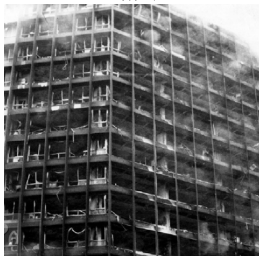
Figura 6 – Incêndio no Edifício Joelma – foto 2.
