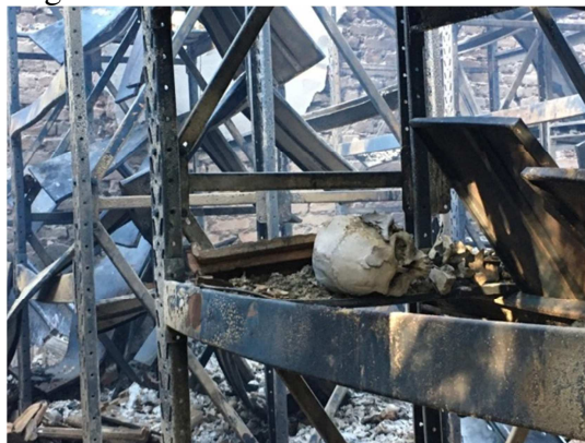
Figura 18 – Incêndio na UFMG – foto 2.
