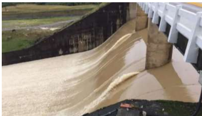
Figura 43 - Barragem de Ituporanga.
