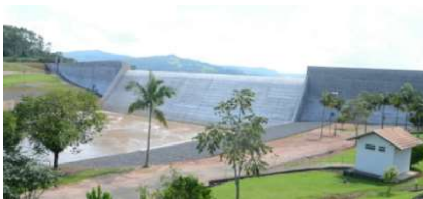
Figura 42 - Barragem do município de Taió.
