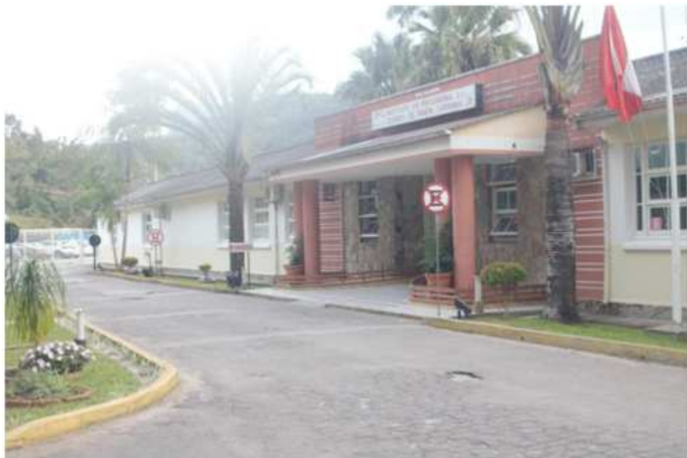
Figura 5 – Fachada Central do IPq
