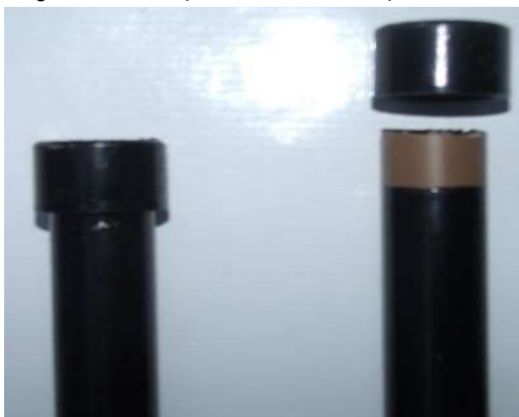
Figura 95 - Colocação das buchas de redução nos canos.
