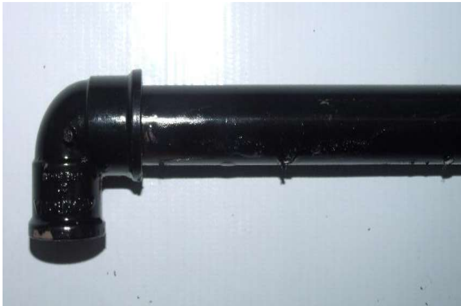
Figura 103 - Colocação do joelho de 90° ao cano.
