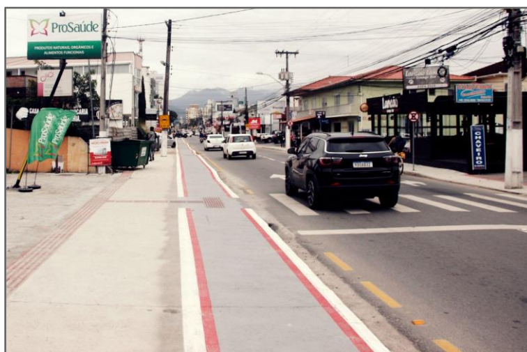
Figura 12 - Início da Av. Barão do Rio Branco, próximo à Marginal da BR-101 e Bairro Ponte do Imaruim
