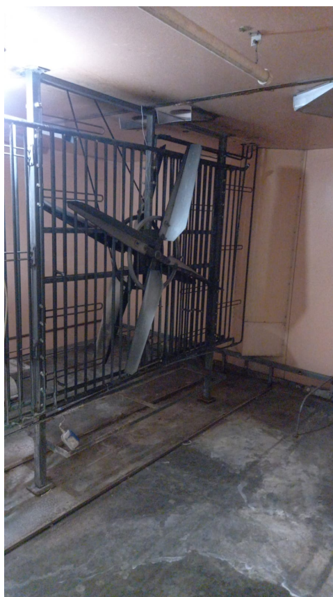
Figura 8 – Sistema de aquecimento e de ventilação de uma câmara de incubação (Avícola Catarinense).
