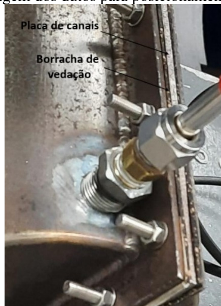
Figura 31 – Soldagem dos dutos para posicionamento do anemômetro.
