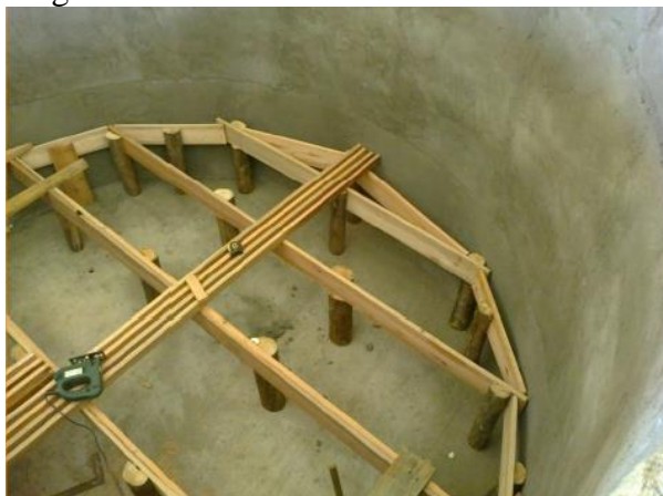
Figura 27 - Construindo o fundo em madeira
