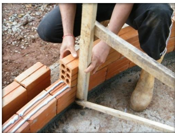
Figura 25 - Colagem dos tijolos com argamassa polimérica
