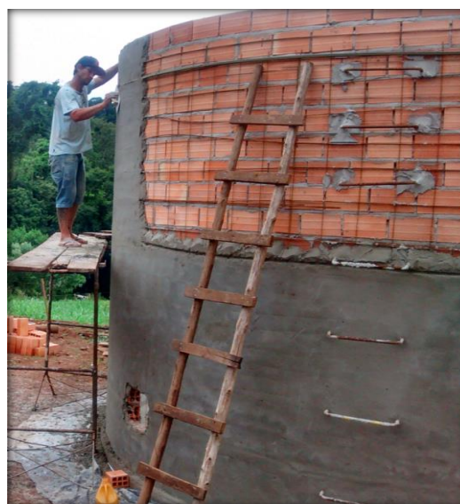
Figura 26 – Alvenaria armada
