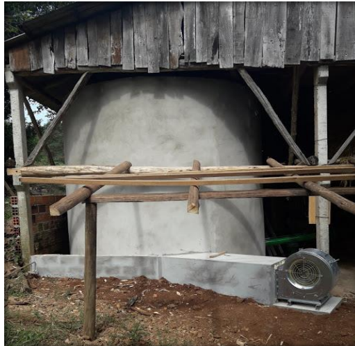
Figura 32 – Unidade com um silo de 250 sacos de capacidade
