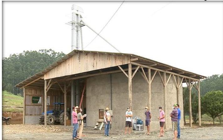
Figura 33 – Unidade com um silo de 5000 sacos de capacidade
