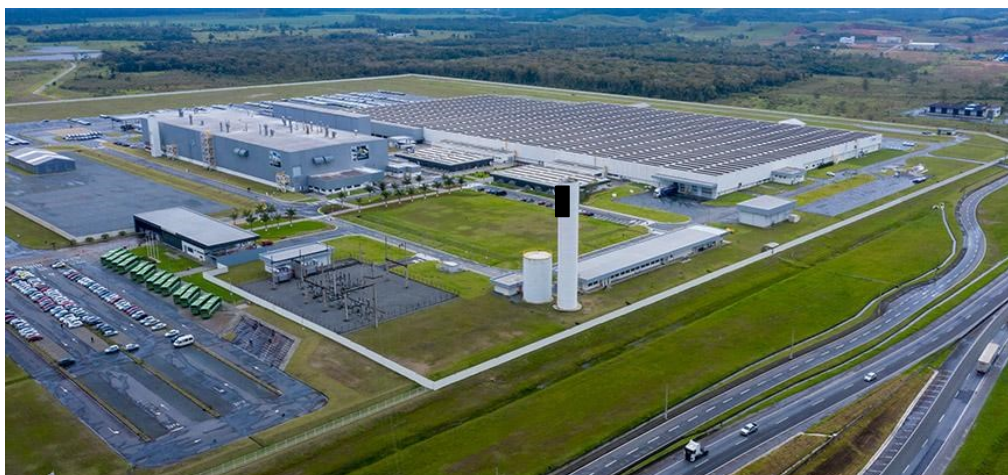
Figura 8 – Imagem aérea da planta industrial.
