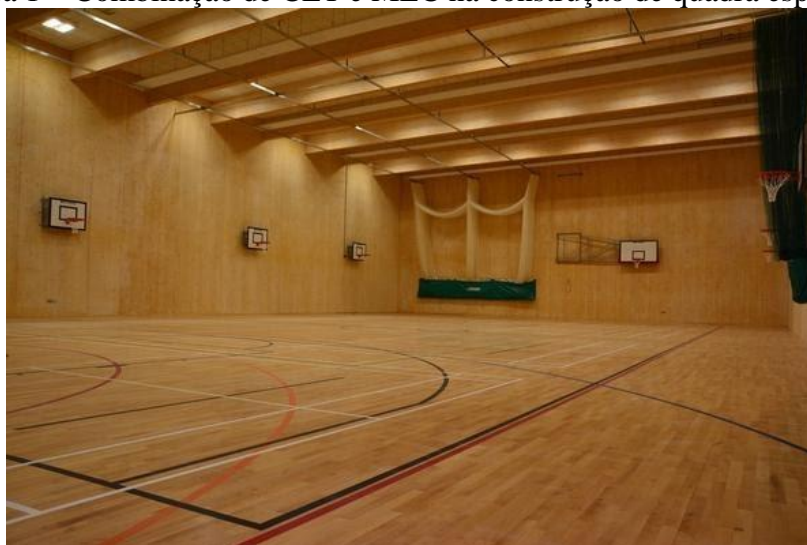
Figura 1 – Combinação de CLT e MLC na construção de quadra esportiva.
