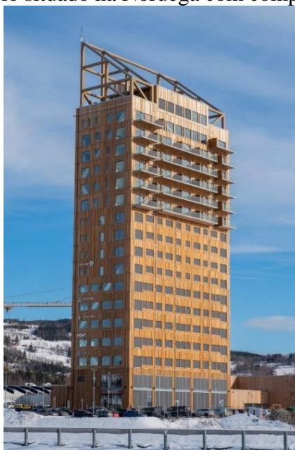
Figura 10 – MjØstårnet, edifício situado na Noruega com componentes de CLT e MLC.
