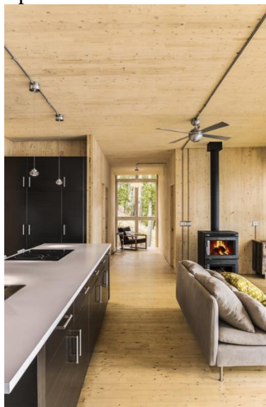
Figura 6 – Uso de painéis de CLT em construção de residência.
