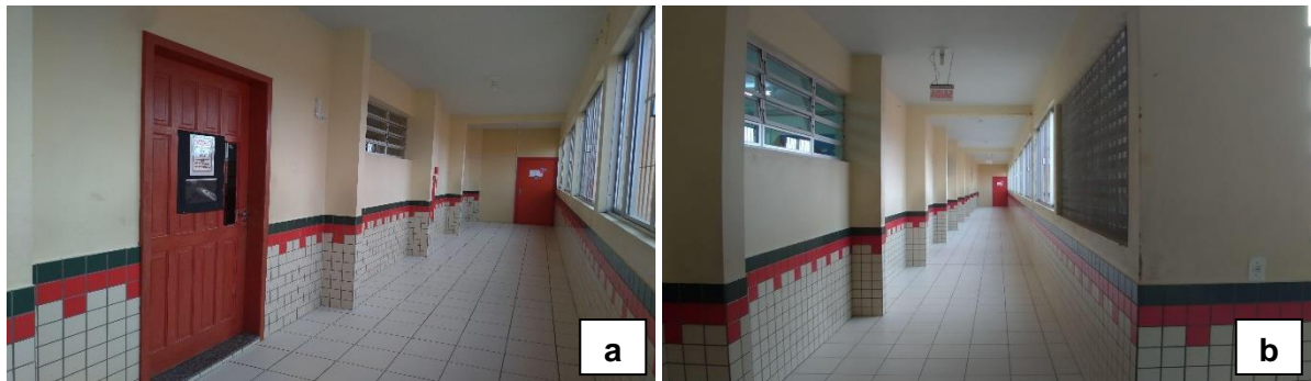
Figura 11 - Estratégia de ventilação cruzada nas áreas de circulação
