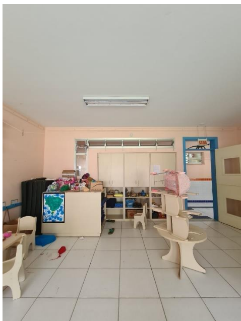
Figura 78 – Aberturas facilitadoras de ventilação do NEIM Hassis
