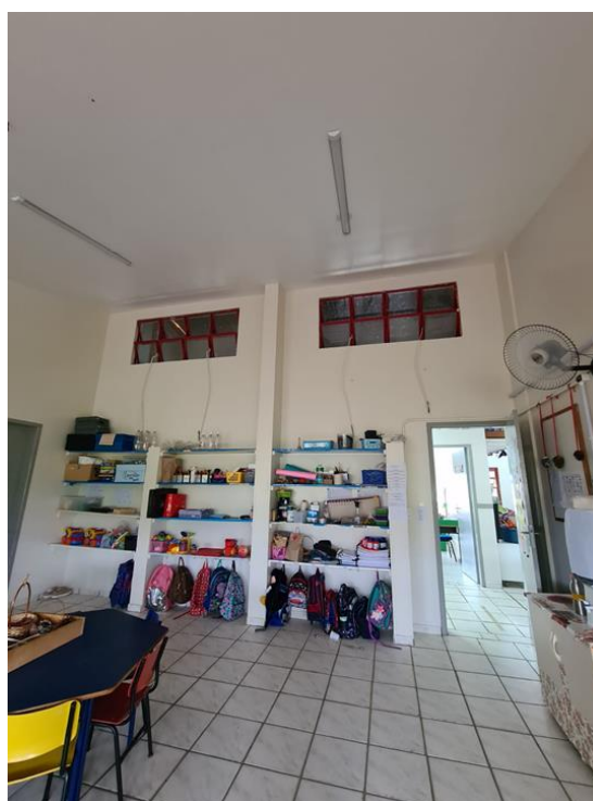
Figura 71 – Aberturas para ventilação e caixas d'água do NEIM Doralice Teodora Bastos
