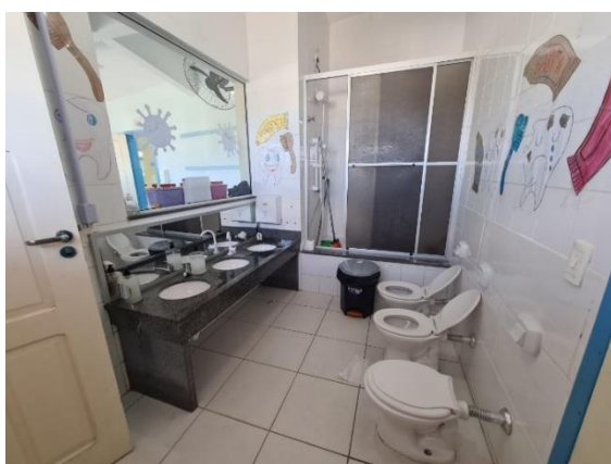
Figura 65 – Banheiro das salas de atendimento 1 e 2 do NEIM Nagib Jabor
