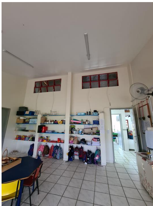
Figura 30 – Aberturas para ventilação e caixas d’água do NEIM Doralice Teodora Bastos
