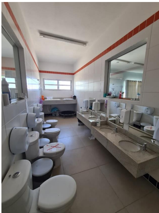
Figura 45 – Banheiro da entrada
