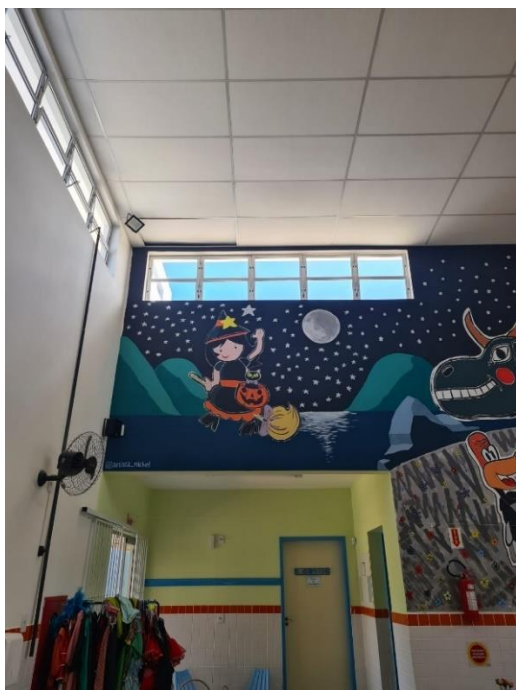
Figura 25 – Janelas do átrio central do NEIM – sul e leste
