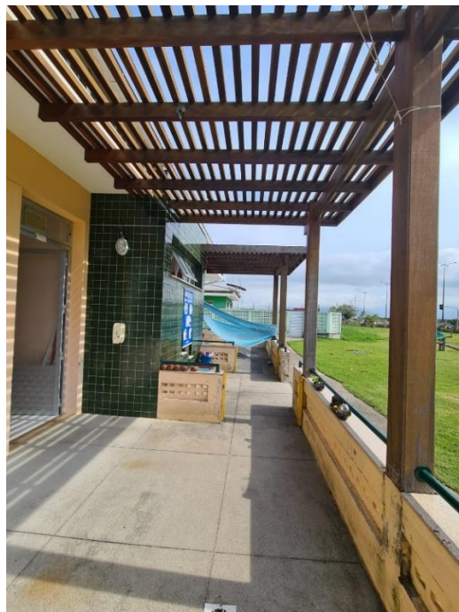
Figura 77 – Gazebo nos solários do NEIM Hassis
