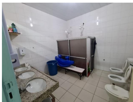
Figura 66 – Banheiro da Sala de Atendimento 3 do NEIM Nagib Jabor
