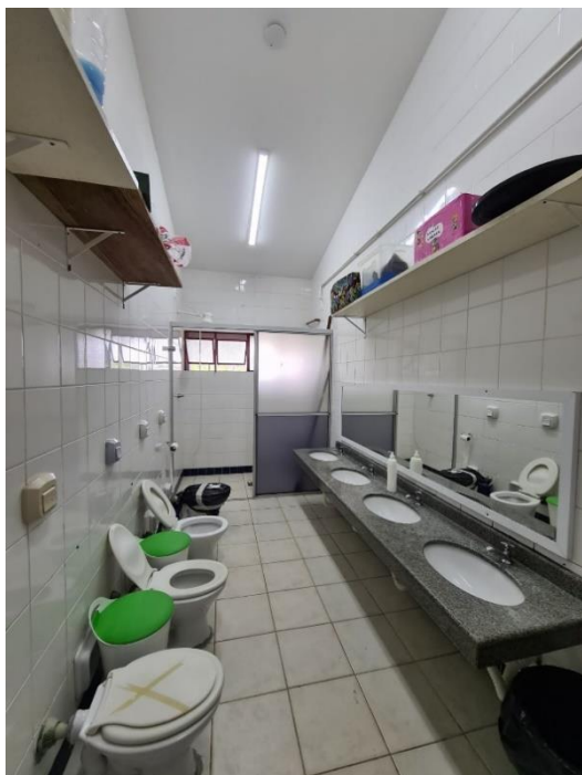
Figura 72 – Banheiro entre as salas de atendimento 4 e 5 do NEIM Doralice Teodora Bastos
