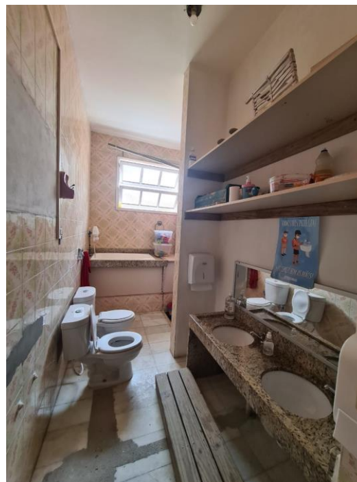
Figura 56 – Banheiro das salas de atendimento 4 e 5 do NEIM Cristo Redentor
