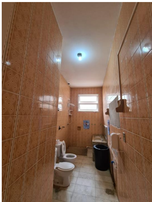
Figura 55 – Banheiro das salas de atendimento 2, 3 e 4 do NEIM Cristo Redentor
