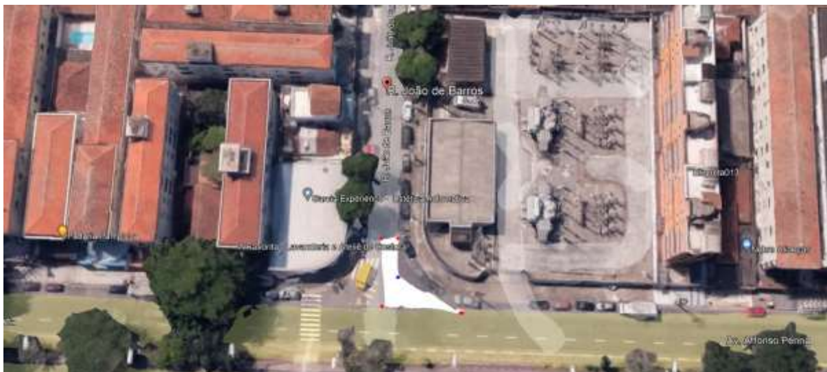
Figura 20 – Projeção do trecho repavimentado na Avenida Afonso Pena (Área 1)
