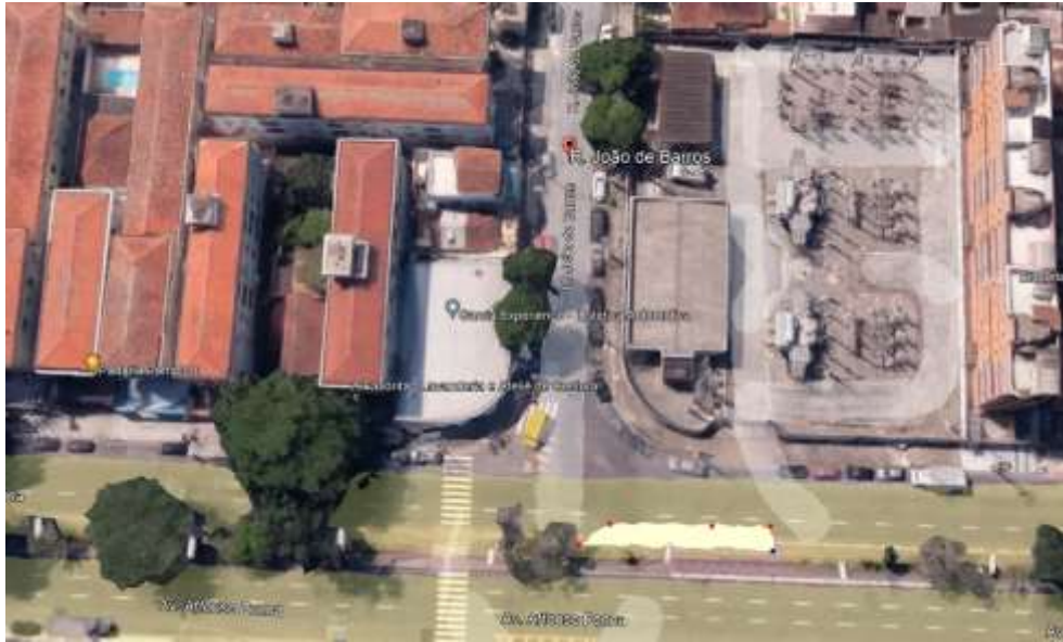
Figura 30 – Projeção do canteiro de obras da Avenida Afonso Pena
