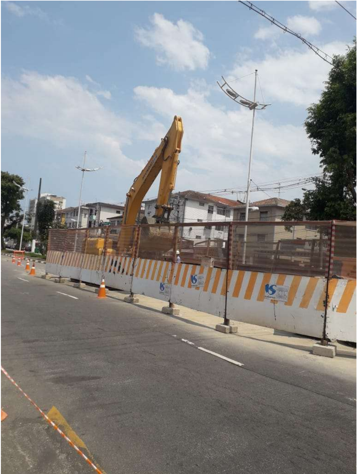
Figura 11 – Canteiro de obras da Avenida Afonso Pena em detalhe
