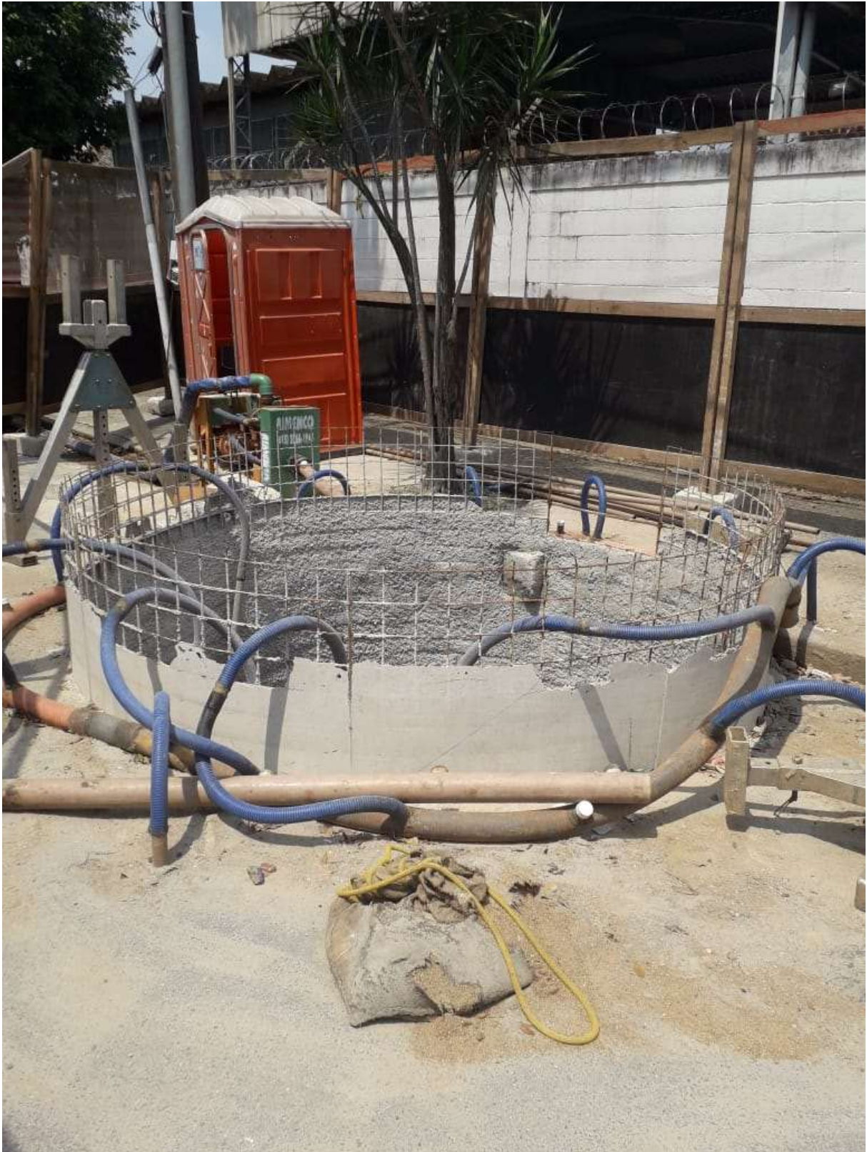
Figura 26 – Vista externa do poço
