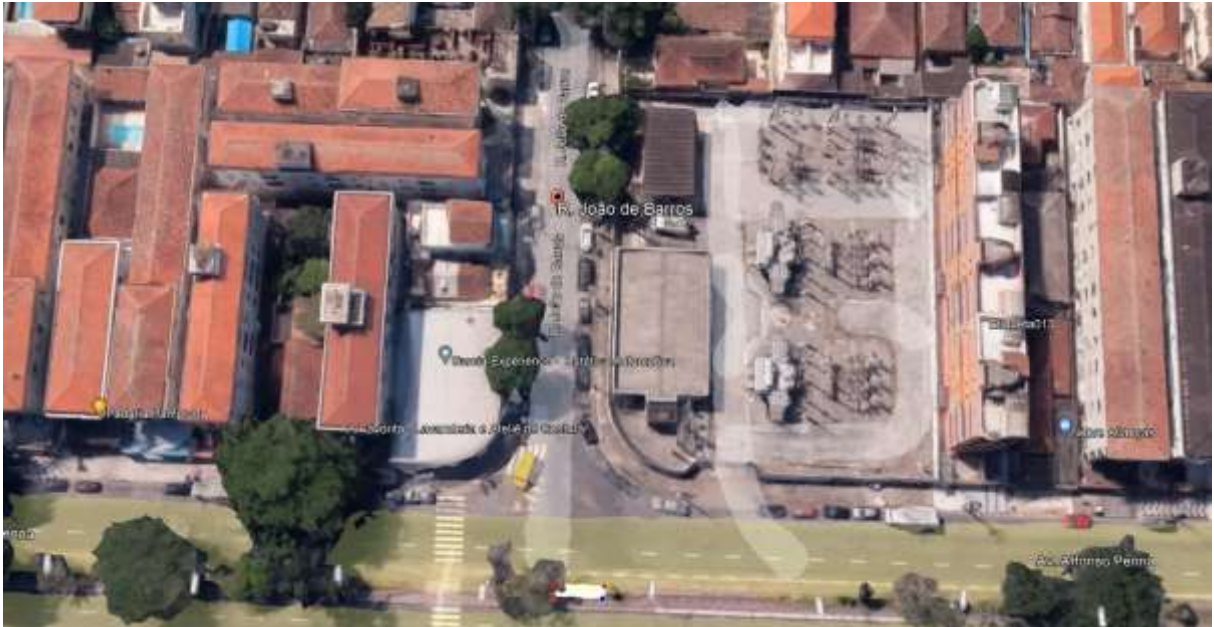
Figura 24 – Projeção do trecho repavimentado na Avenida Afonso Pena (Área 3)
