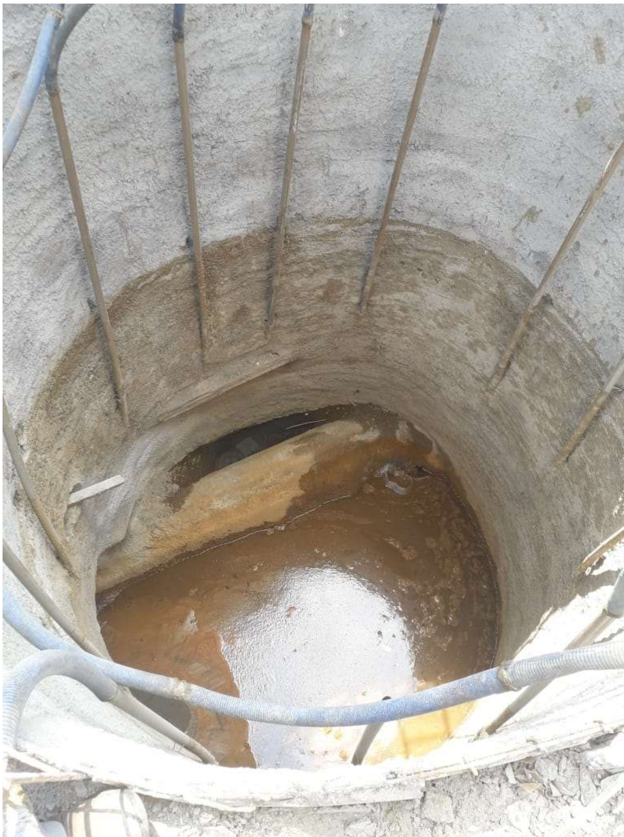
Figura 27 – Vista interna do poço
