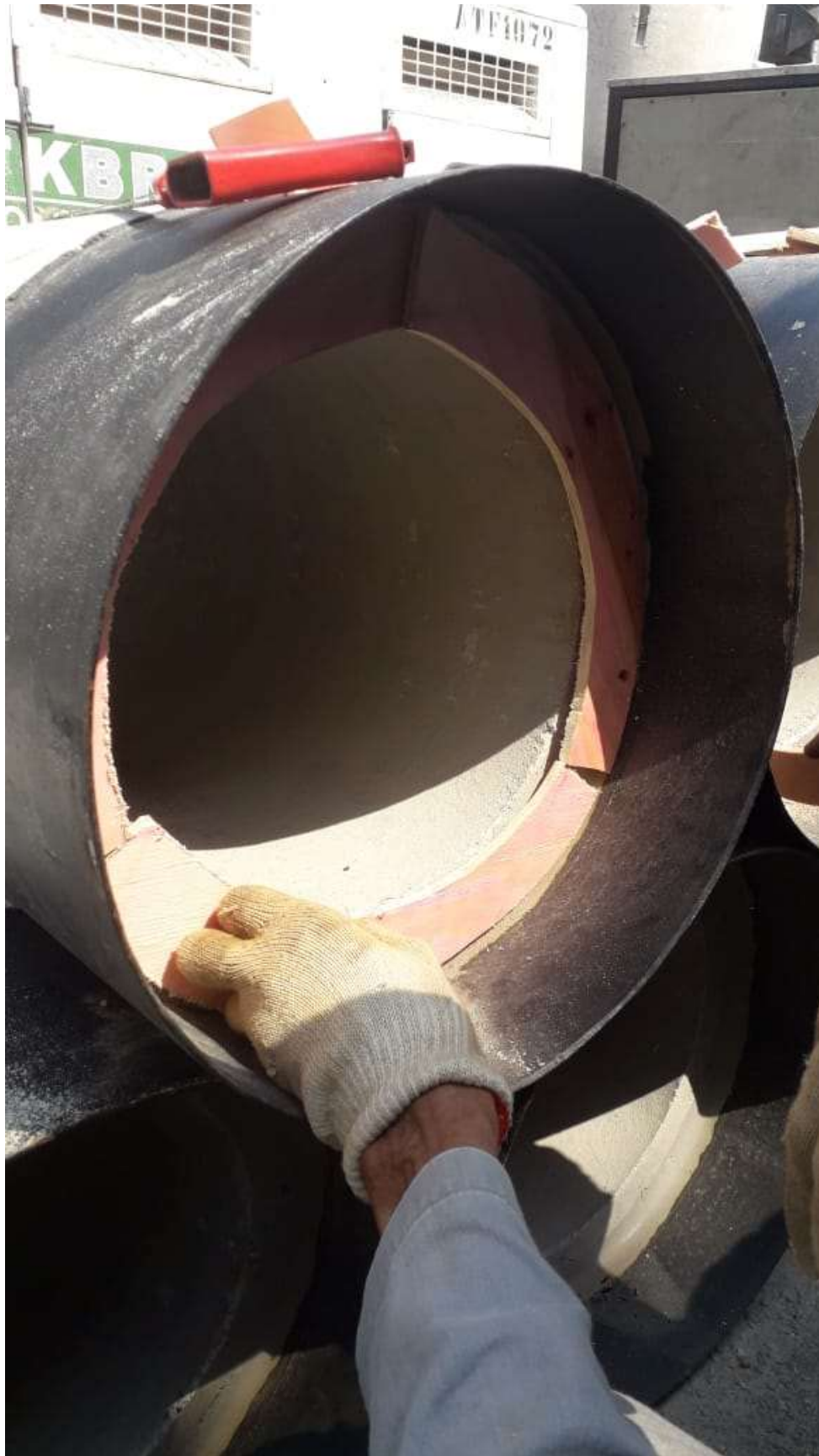
Figura 5 – Tubos utilizados após prévia preparação para evitar danos durante seu encaixe
