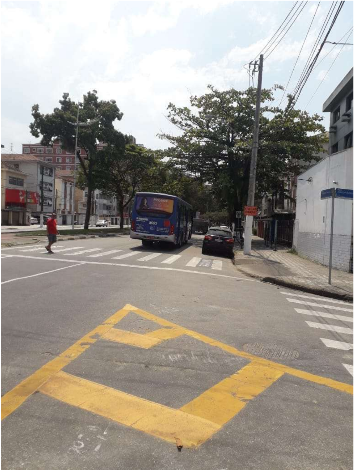
Figura 7 – Liberação completa da avenida após o trecho em obras
