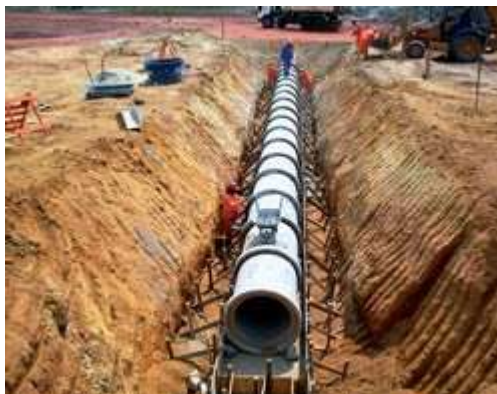
Figura 1 – Abertura de vala pelo método destrutivo
