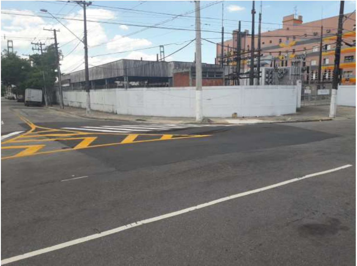
Figura 18 – Trecho repavimentado na Rua João de Barros com Avenida Afonso Pena (Área 1)
