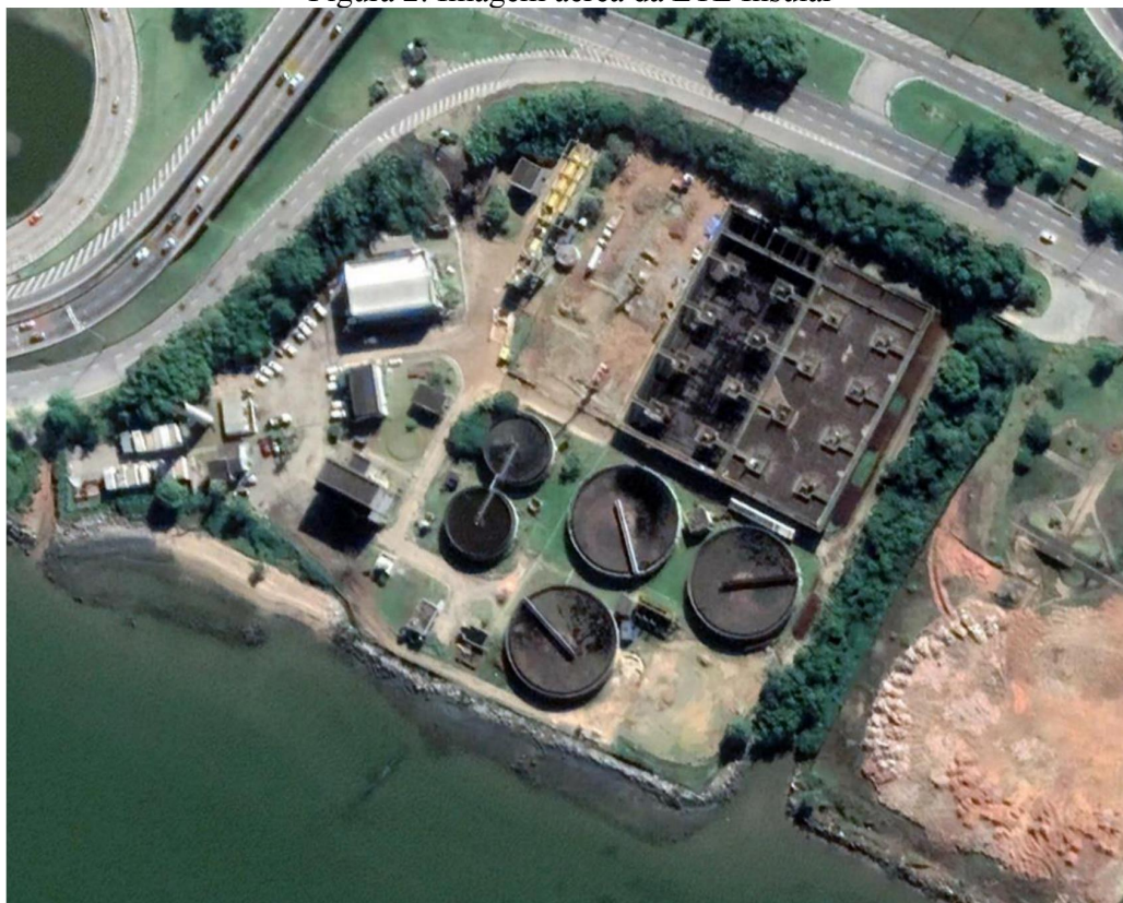
Figura 2: Imagem aérea da ETE Insular
