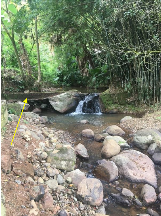
Ribeirão Diamante – Barramento artificial para entrada nas valas de irrigação.
