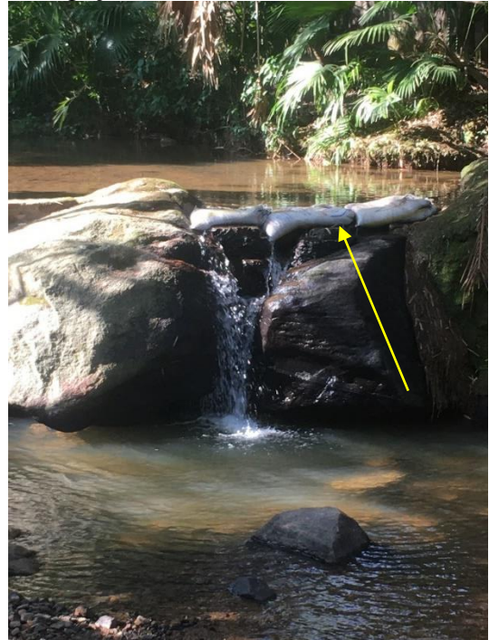
Ribeirão Diamante – Sacos com areia para barrar o curso d'água e desviar para as valas de irrigação
