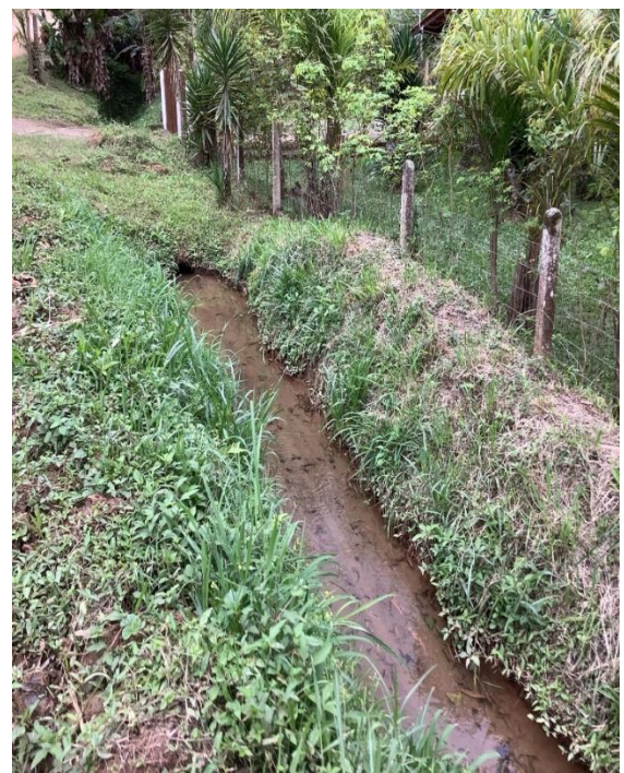
Vala de irrigação – desvio do Ribeirão Diamante
