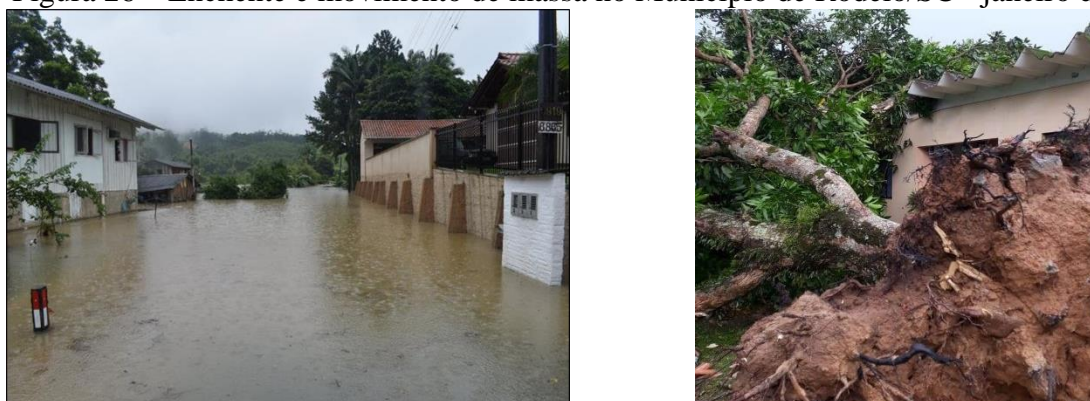
Figura 26 – Enchente e movimento de massa no Município de Rodeio/SC - janeiro de 2021
