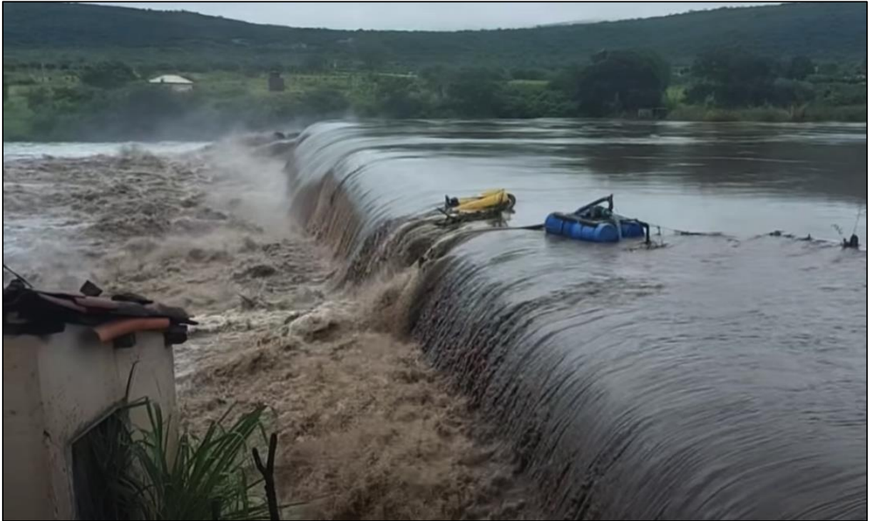
Figura 2 - Inundação no vale de jusante após rompimento da barragem próxima ao município de Jussiape (BA).
