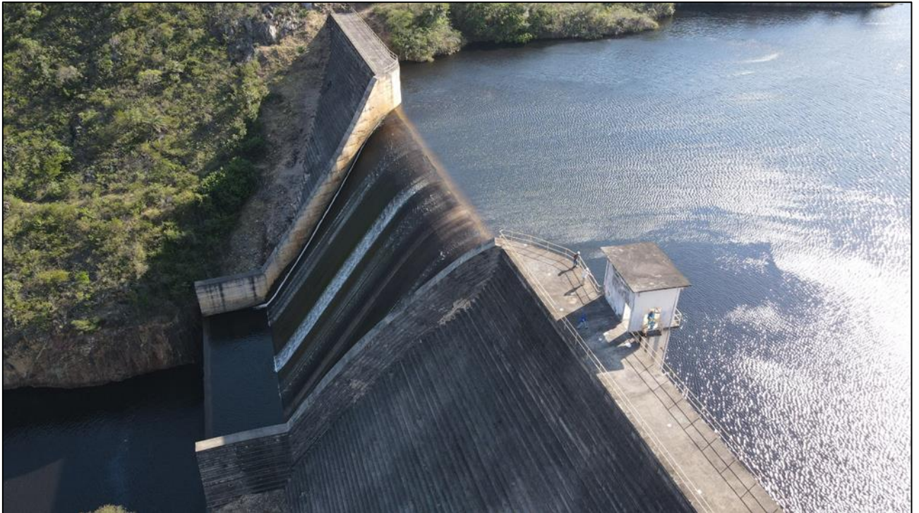
Figura 7 - Vista Aérea da Estrutura Extravasora da Barragem de Pindobaçu.
