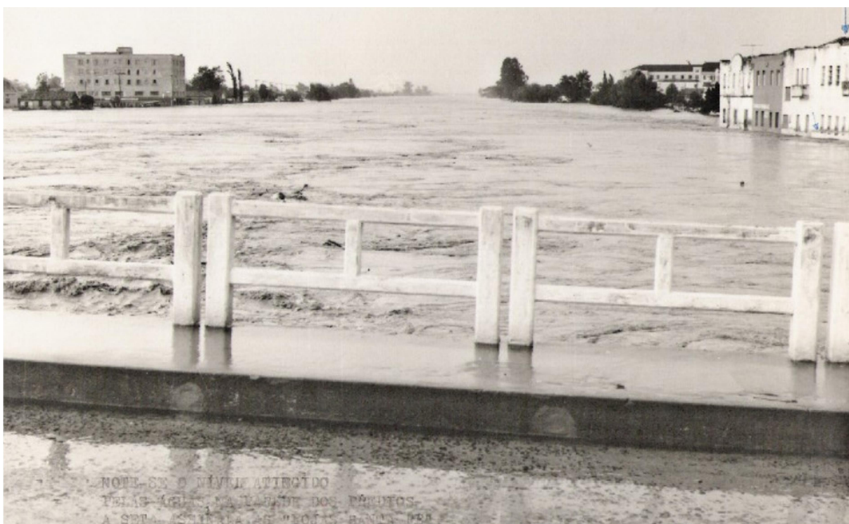
Figura 17 – Vista da Ponte Nereu Ramos - momento em que o rio reivindica seu espaço – Fonte: Patrimônio Histórico Municipal
