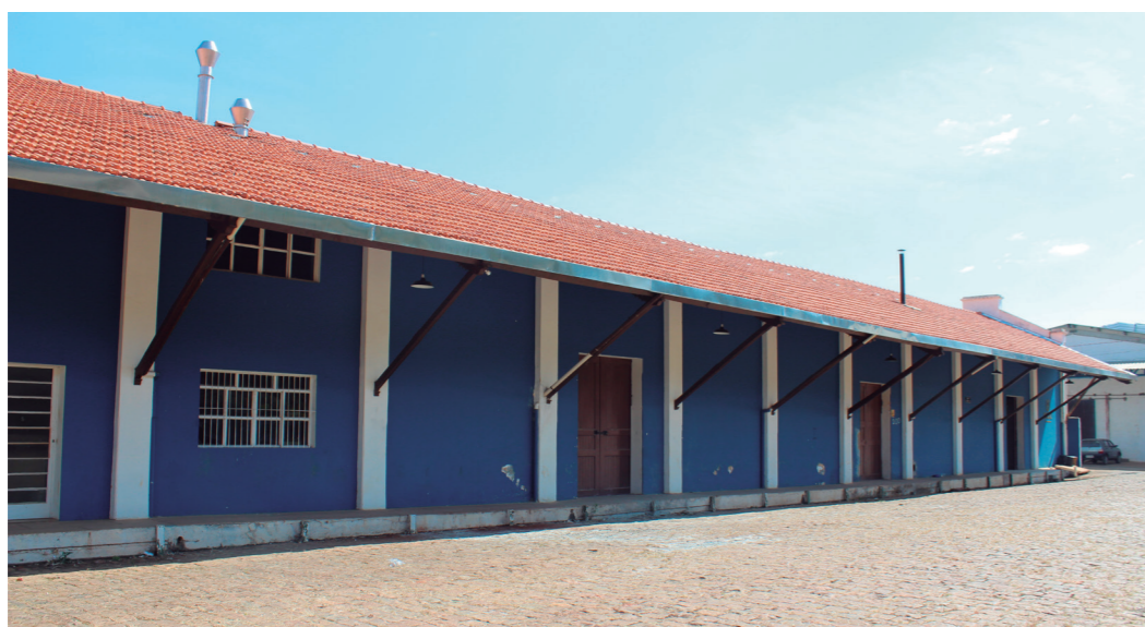
IMAGEM 42: Detalhe das pilastras apoiando as mãos francesas (Foto: Arquivo Pessoal)
