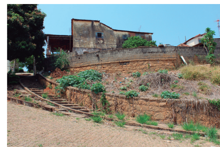
IMAGEM 45: Muro de arrimo delimitando o desenho da praça (Foto: Arquivo Pessoal)
