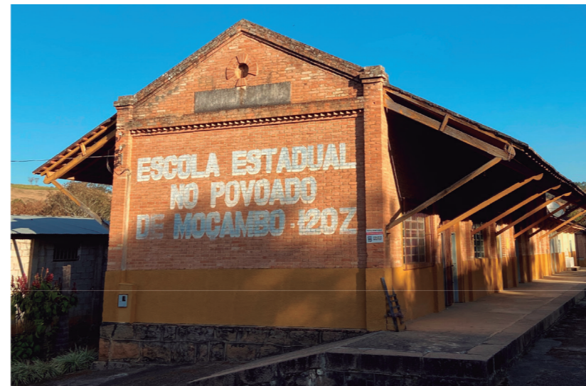
IMAGEM 15: Estação do Moçambo, 2021 (Fonte: Foto da autora)
