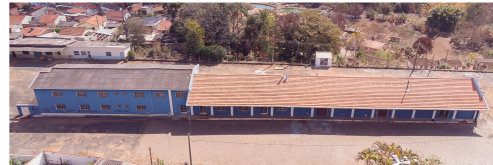
IMAGEM 30: Fachada leste, edifício em 2021 (Foto: Arquivo pessoal)
