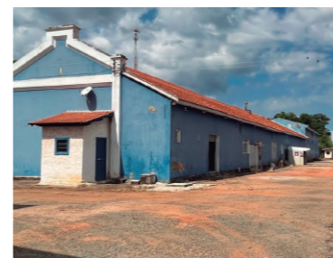
01 - Paredes construídas em 1970 fechando a antiga plataforma de embarque.
