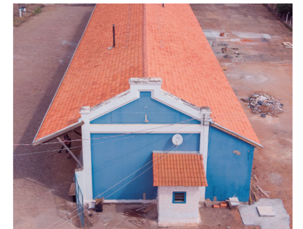
IMAGEM 32: Fachada norte, edifício em 2021 (Foto: Arquivo pessoal)
