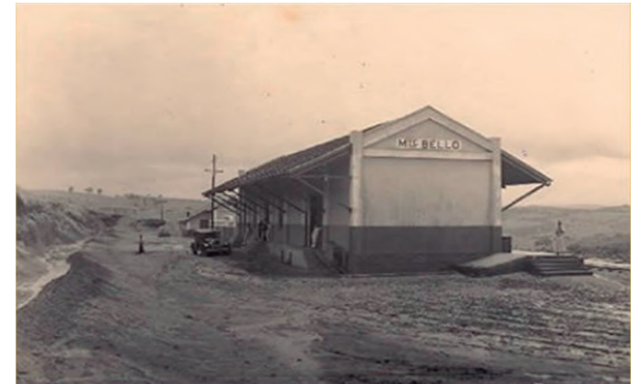
IMAGEM 23: Estação de Monte Belo, anos 1960 (Fonte: Internet Archive)
