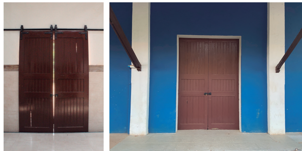
IMAGEM 38 e 39: Portas originais em madeira com roldanas sob trilhos (Foto: Arquivo Pessoal)
