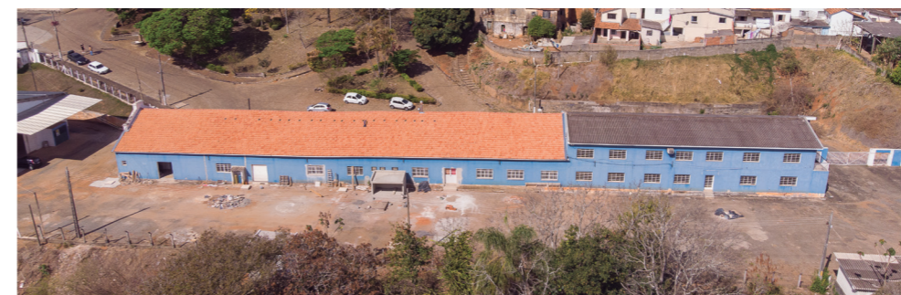
IMAGEM 31: Fachada oeste, edifício em 2021 (Foto: Arquivo pessoal)
