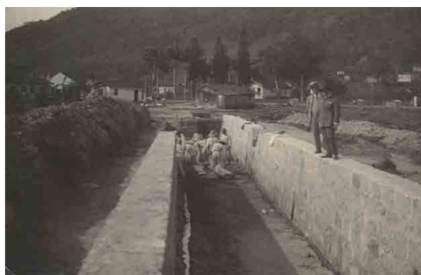
Canalização da Fonte Grande, início do século XX. Homens trabalhando próximo à Rua das Olarias no sopé do Morro do Antão. Fonte: Tese de doutorado Do Mar ao Morro (SANTOS, 2009, p.494)
