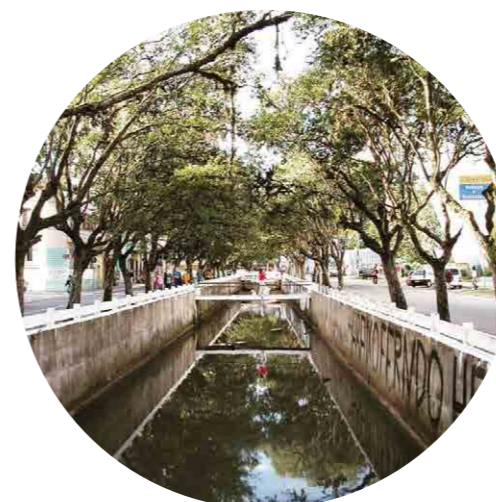
Rio da Bulha em 2005, já canalizado mas aberto, no trecho em frente ao IEE. Fonte: Jornalista Carlos Damião.
