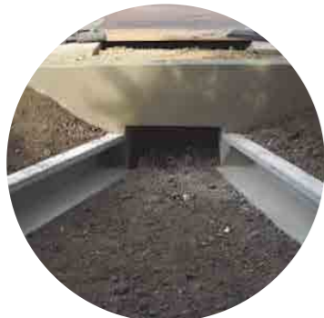
Passagem subterrânea sob vias para pequenos animais terrestres. Fonte: página do Conecte Bio.
