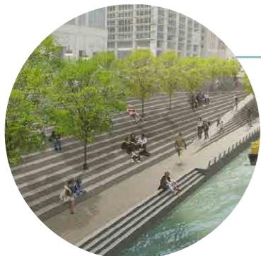
Escadaria e rampa acessível, fazendo a aproximação do público com o rio e funcionando como área de estar e de contemplação. Fonte: página Archdaily, galeria do Projeto Chicago Riverwalk.
