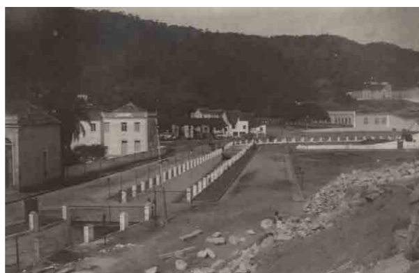
Fonte Grande, 1922. Avenida do Saneamento em obras, já com as duas alamedas construídas sobre áreas de cortiços demolidos. À direita, a retirada de rochas da antiga Pedreira. Fonte: Tese de doutorado Do Mar ao Morro (SANTOS, 2009, p.511)
