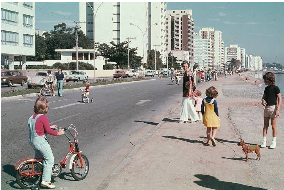
Figura 1 – Avenida Beira-Mar Norte, na década de 1970, uma das principais obras públicas da época.
