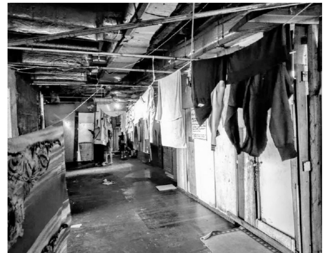
Ocupação Edifício Wilton Paes de Almeida - SP (antes do incêndio) Fotografia por Lidiane Maciel
