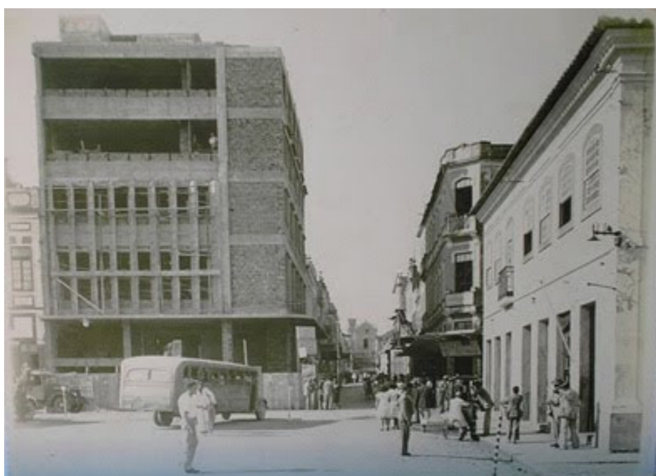
Construção do prédio do IPESC na esquina da Rua Trajano com a Rua Conselheiro Mafra na década de 1950. Imagem disponível no site Florianópolis e Hoje
