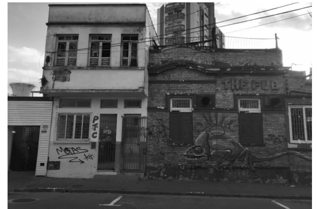
Imóveis abandonados e degradados no centro de Florianópolis Fotografia por autoria própria
